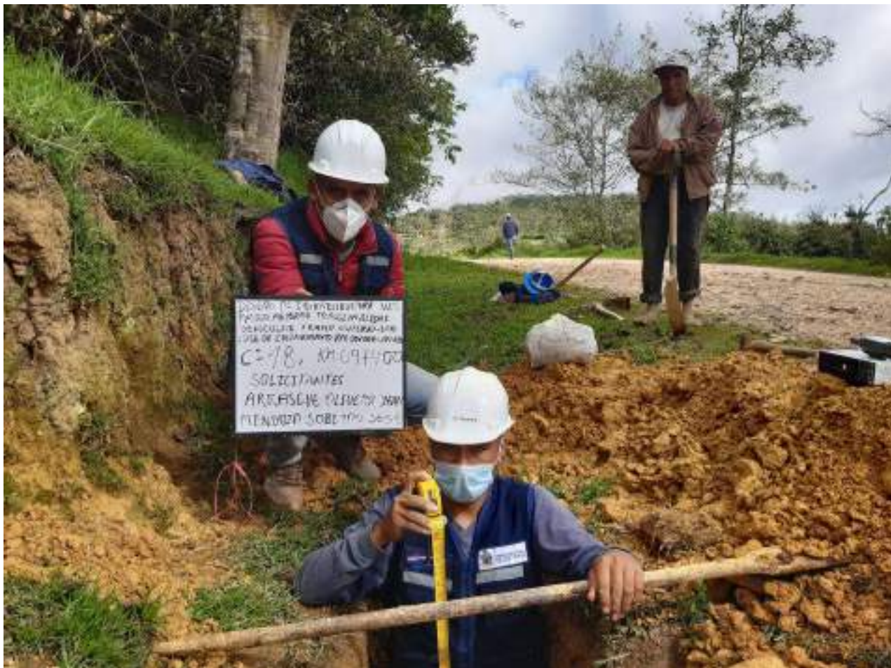
FOTOGRAFIA 18: Se Observa La Toma De Muestras De La C - 18 Para La Tesis: " Diseño De Infraestructura Vial Para Mejorar La Transitabilidad Vehicula Tramo Cutervo –San José De Cullanmayo Km. 00+000 Al Km.10+360, Cajamarca"
