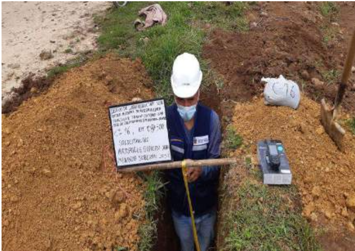
FOTOGRAFIA 16: Se Observa La Toma De Muestras De La C - 16 Para La Tesis: " Diseño De Infraestructura Vial Para Mejorar La Transitabilidad Vehicular Tramo Cutervo –San José De Cullanmayo Km. 00+000 Al Km.10+360, Cajamarca"
