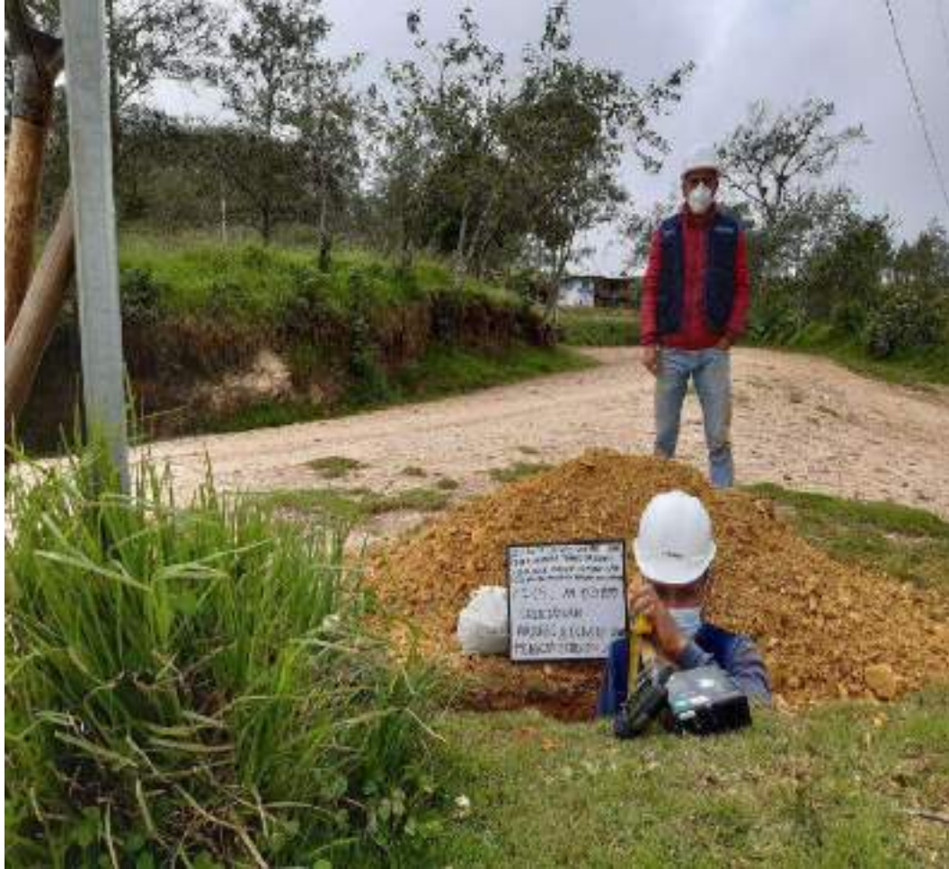
FOTOGRAFIA 05: Se Observa La Toma De Muestras De La C - 5 Para La Tesis: " Diseño De Infraestructura Vial Para Mejorar La Transitabilidad Vehicular Tramo Cutervo –San José De Cullanmayo Km. 00+000 Al Km.10+360, Cajamarca"
