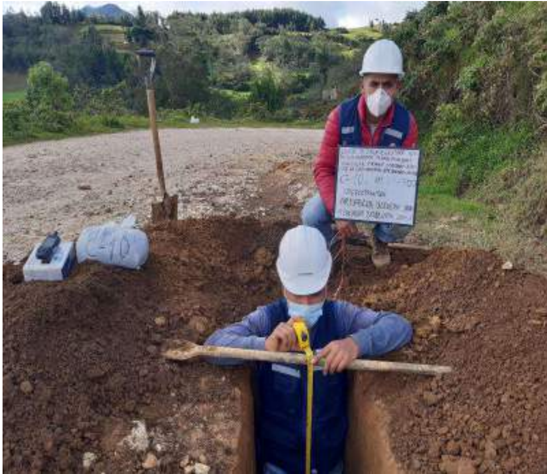
FOTOGRAFIA 10: Se Observa La Toma De Muestras De La C - 10 Para La Tesis: " Diseño De Infraestructura Vial Para Mejorar La Transitabilidad Vehicular Tramo Cutervo –San José De Cullanmayo Km. 00+000 Al Km.10+360, Cajamarca"
