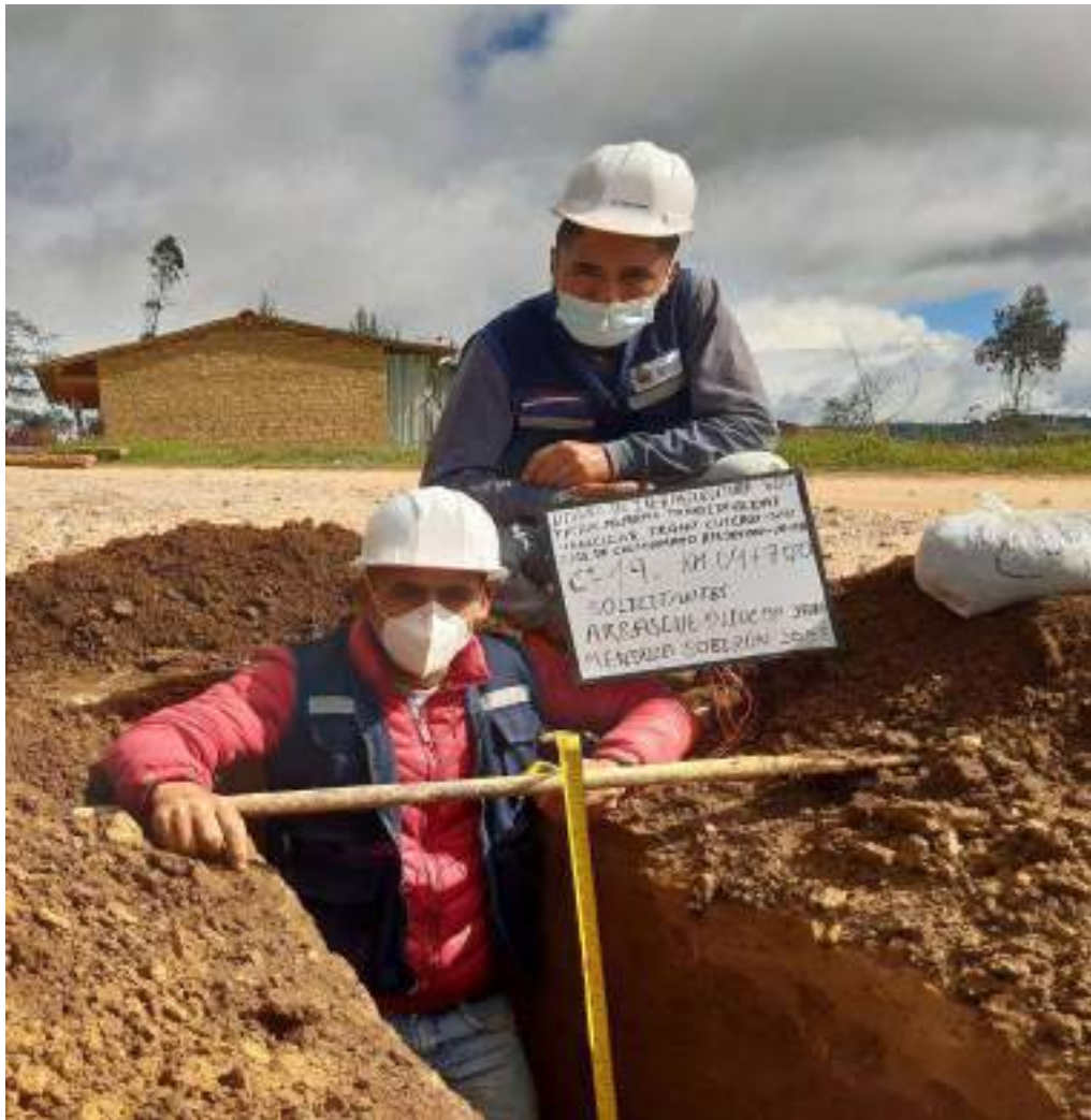
FOTOGRAFIA 19: Se Observa La Toma De Muestras De La C - 19 Para La Tesis: " Diseño De Infraestructura Vial Para Mejorar La Transitabilidad Vehicular Tramo Cutervo –San José De Cullanmayo Km. 00+000 Al Km.10+360, Cajamarca"
