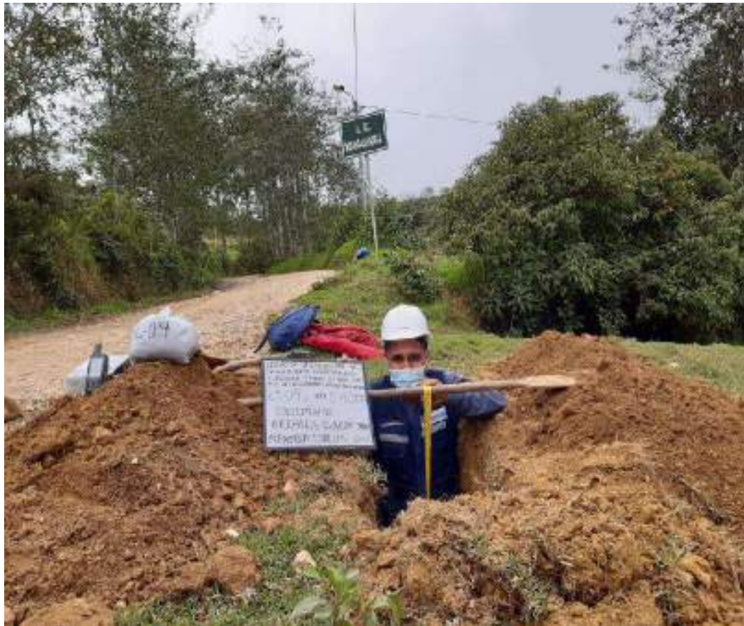
FOTOGRAFIA 09: Se Observa La Toma De Muestras De La C - 9 Para La Tesis: " Diseño De Infraestructura Vial Para Mejorar La Transitabilidad Vehicular Tramo Cutervo –San José De Cullanmayo Km. 00+000 Al Km.10+360, Cajamarca"
