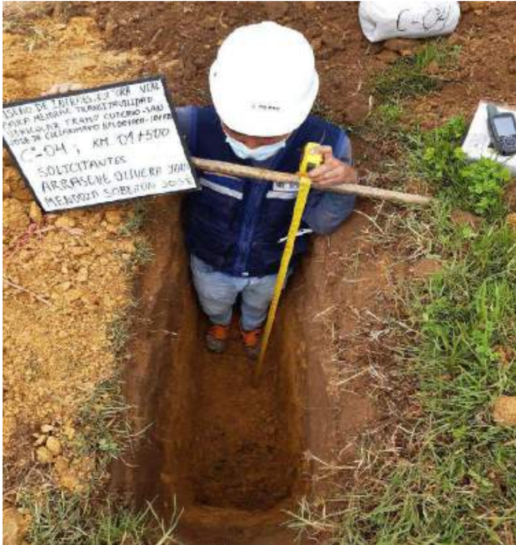
FOTOGRAFIA 04: Se Observa La Toma De Muestras De La C - 4 Para La Tesis: " Diseño De Infraestructura Vial Para Mejorar La Transitabilidad Vehicular Tramo Cutervo –San José De Cullanmayo Km. 00+000 Al Km.10+360, Cajamarca"
