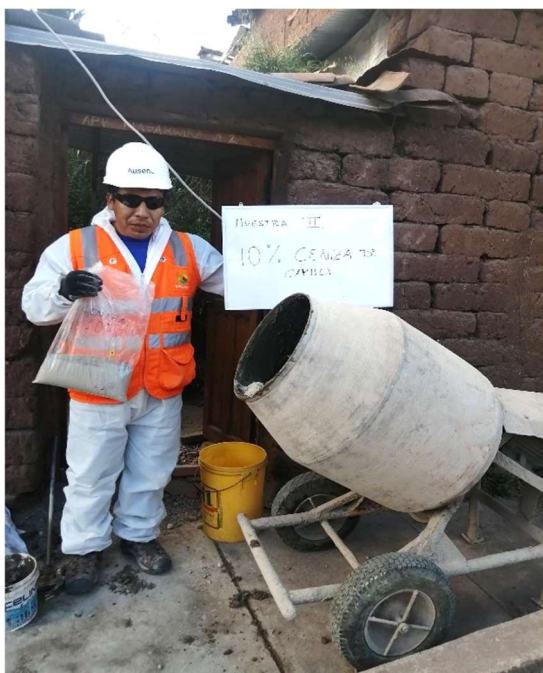
Figura N°14: Elaboración de mezcla.
