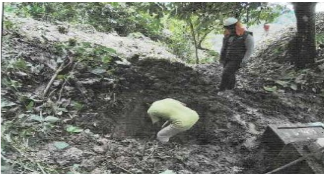
FOTO N°07: CALICATA 03 A CIELO ABIERTO – RESERVORIO
