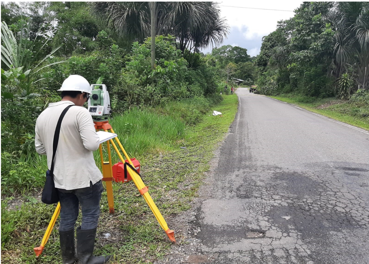
FOTO N°04: LEVANTAMIENTO DE LAS REDES DE DISTRIBUCIÓN
