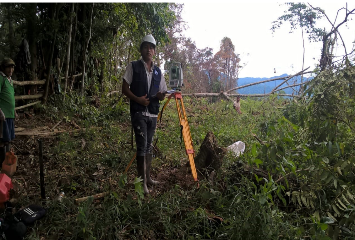
FOTO N°02: ÁREA DONDE SE PROYECTARÁ SEDIMENTADOR Y RESERVORIO
