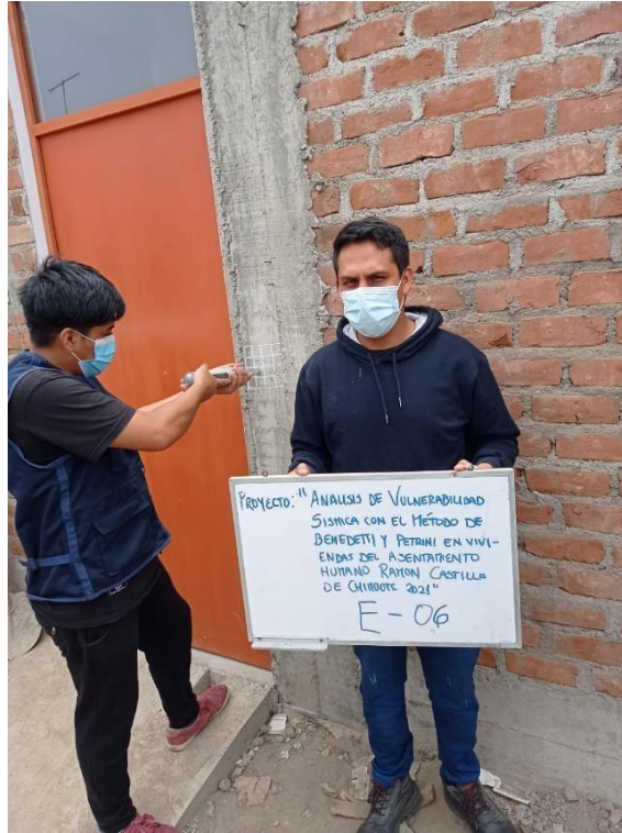
FOTO N°03: Realizando ensayo de esclerometría en E-06
