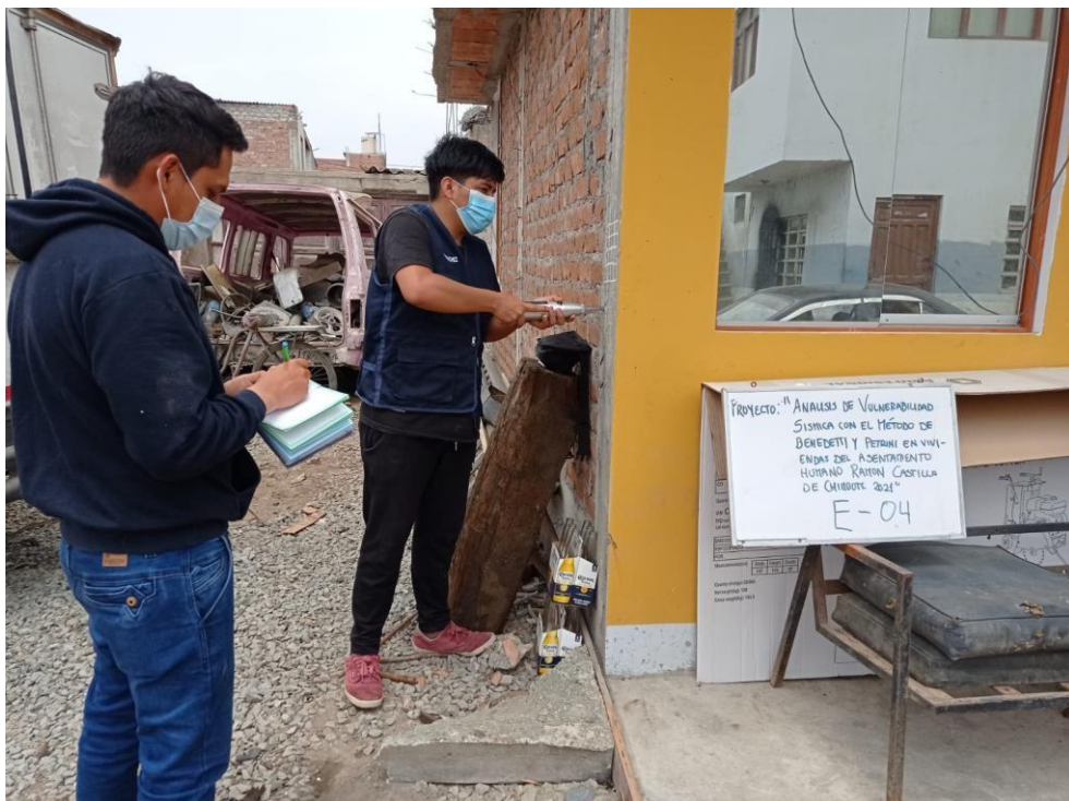
FOTO N°02: Realizando ensayo de esclerometría en E-04
