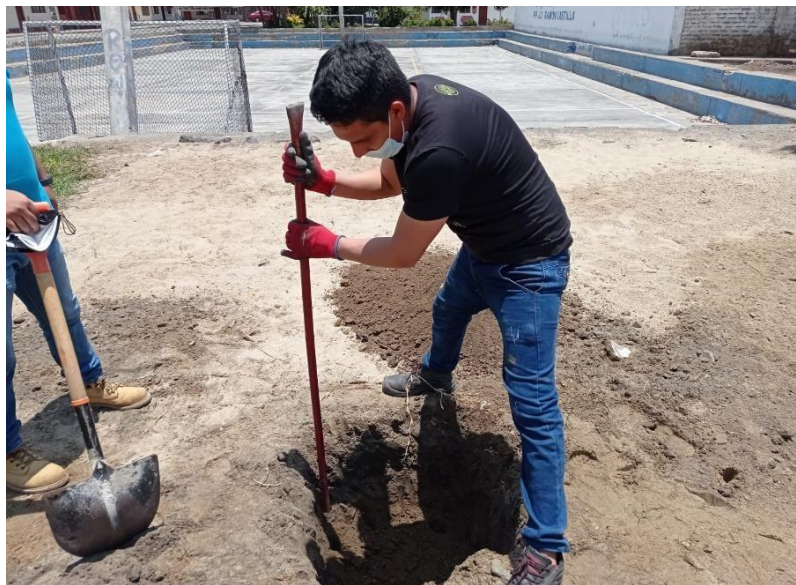
FOTO N°02: Realizando excavación de Calicata C-02
