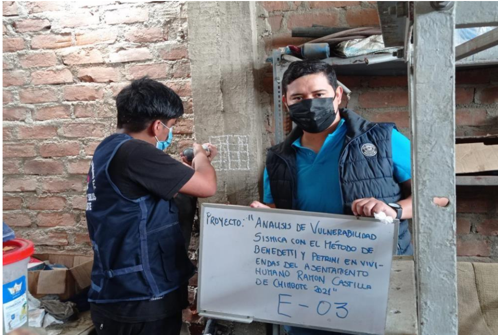
FOTO N°01: Realizando ensayo de esclerometría en E-03
