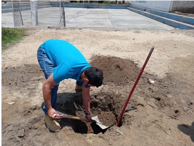
FOTO N°01: Realizando excavación de Calicata C-01
