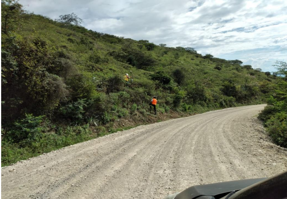
FIGURA 3: Tramo Nueva Victoria – Espital, Km. 0+000 al Km. 5+960, Amazonas –Vista panorámica del estado actual por tramo (Km 3+400), 2021.
