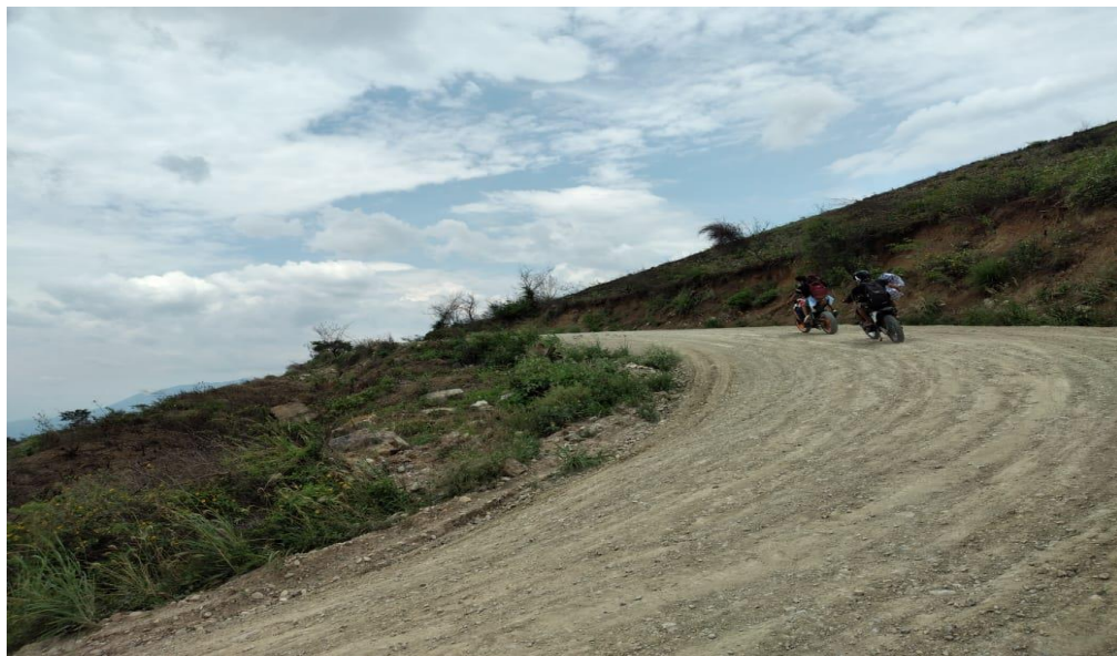
FIGURA 4: Tramo Nueva Victoria – Espital, Km. 0+000 al Km. 5+960, Amazonas –Vista panorámica del estado actual por tramo (Km 4+200), 2021.
