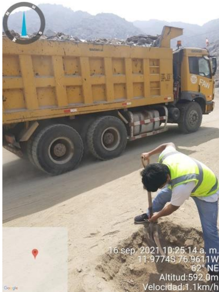
Panel Fotográfico 3. Excavando de calicata
