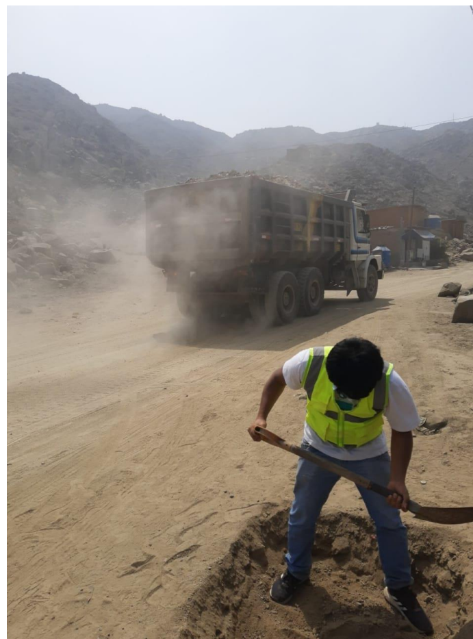
Panel Fotográfico 2. Inicio de excavación.
