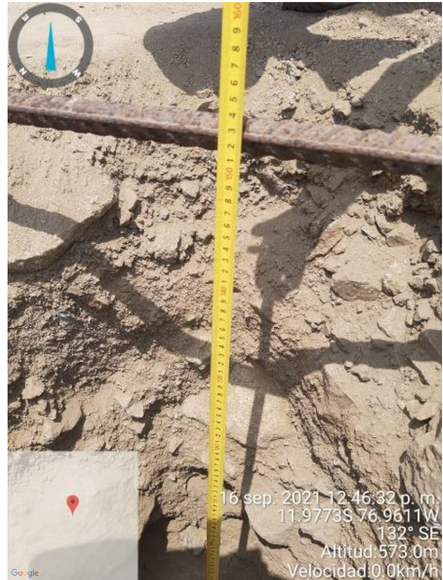
Panel Fotográfico 4. Medición de profundidad de calicata
