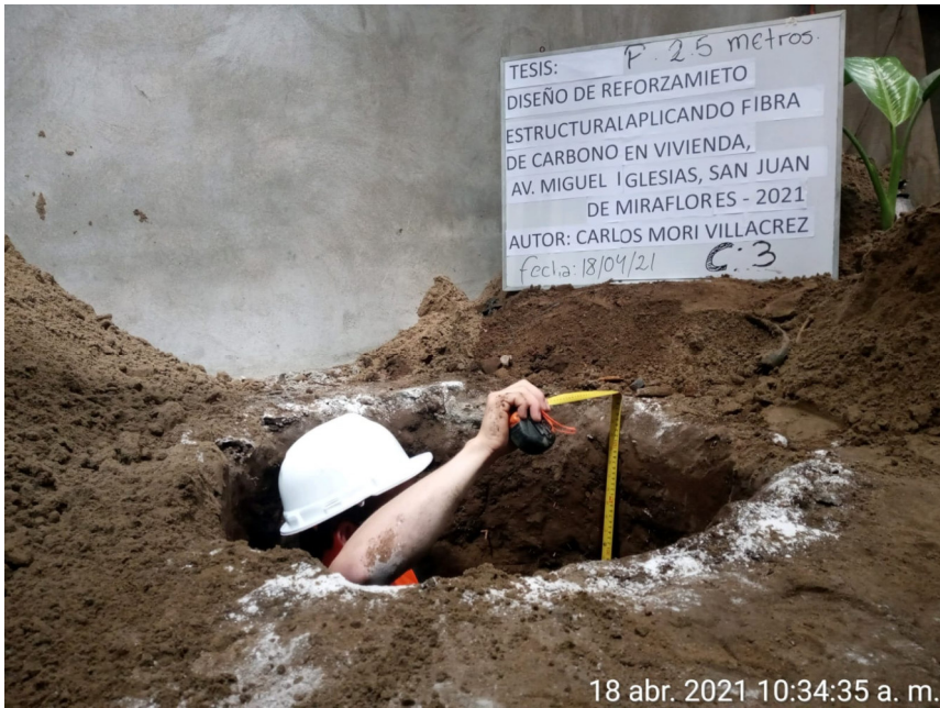
Figura 10. Medición de la calicata.
