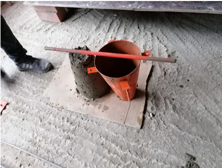
Figura 26. Medición de Slump.
