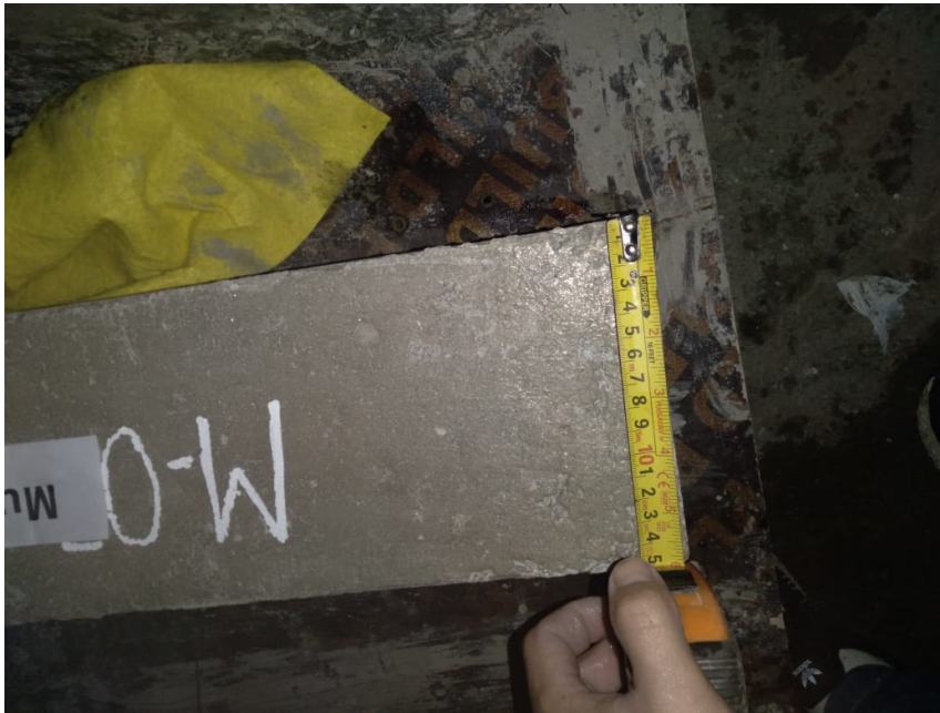
Figura 33. Medición de las vigas
