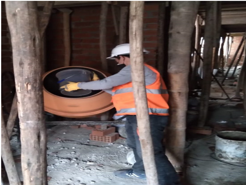
Figura 22. Mezcladora para la mezcla de concreto.
