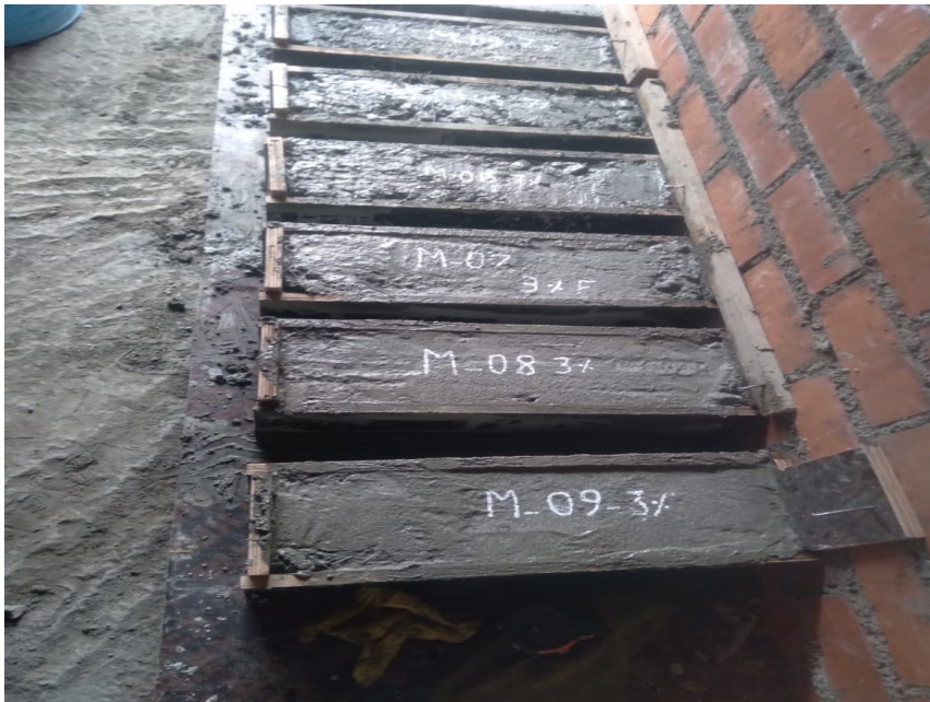
Figura 30. Término de vaciado de concreto en vigas.
