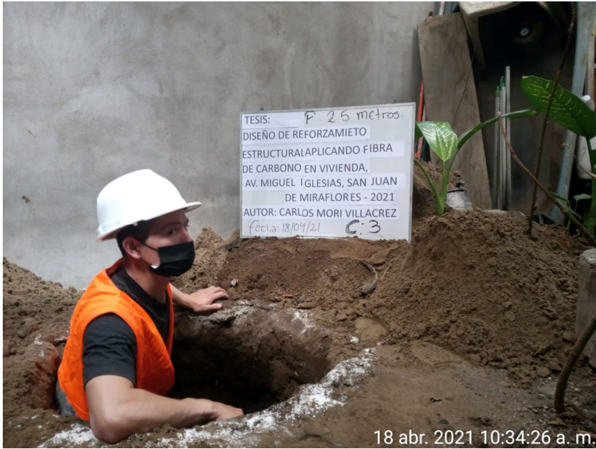
Figura 9. Culminando la calicata
