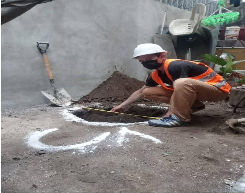
Figura 1. Excavación de calicata.
