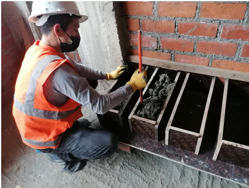
Figura 28. Vaciado de concreto para las vigas
