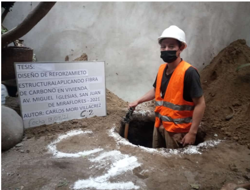
Figura 1. Excavación de calicata.
