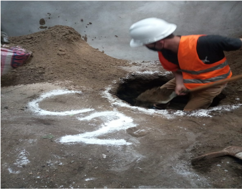
Figura 3. Excavación de calicata.
