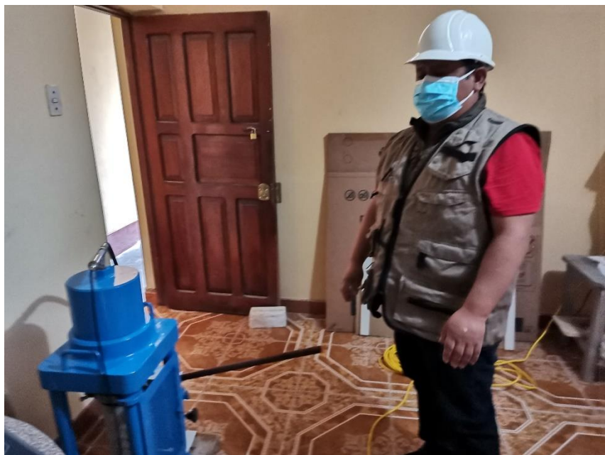
Figura e: Realización de ensayo de resistencia a la compresión por parte del tesista
