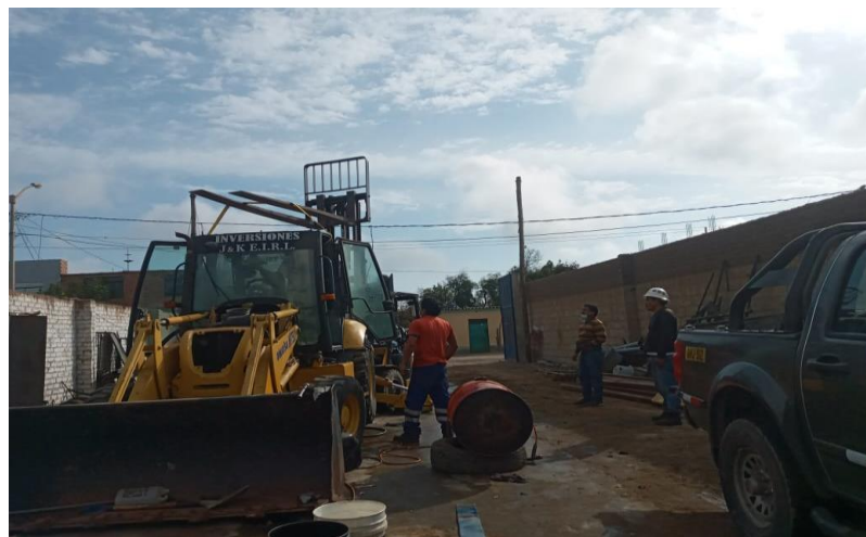
Figura 49: Pruebas por parte del personal de mantenimiento
