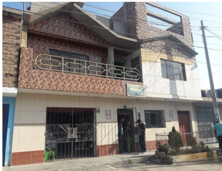
Figura 29. Vivienda de albañilería confinada encuestada
