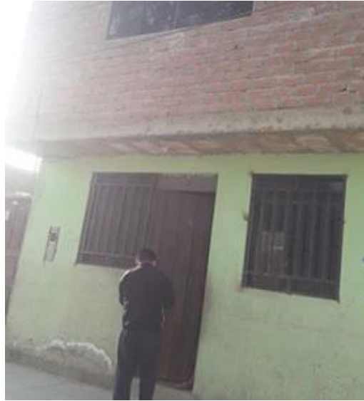
Figura 6. vivienda de albañilería confinada
