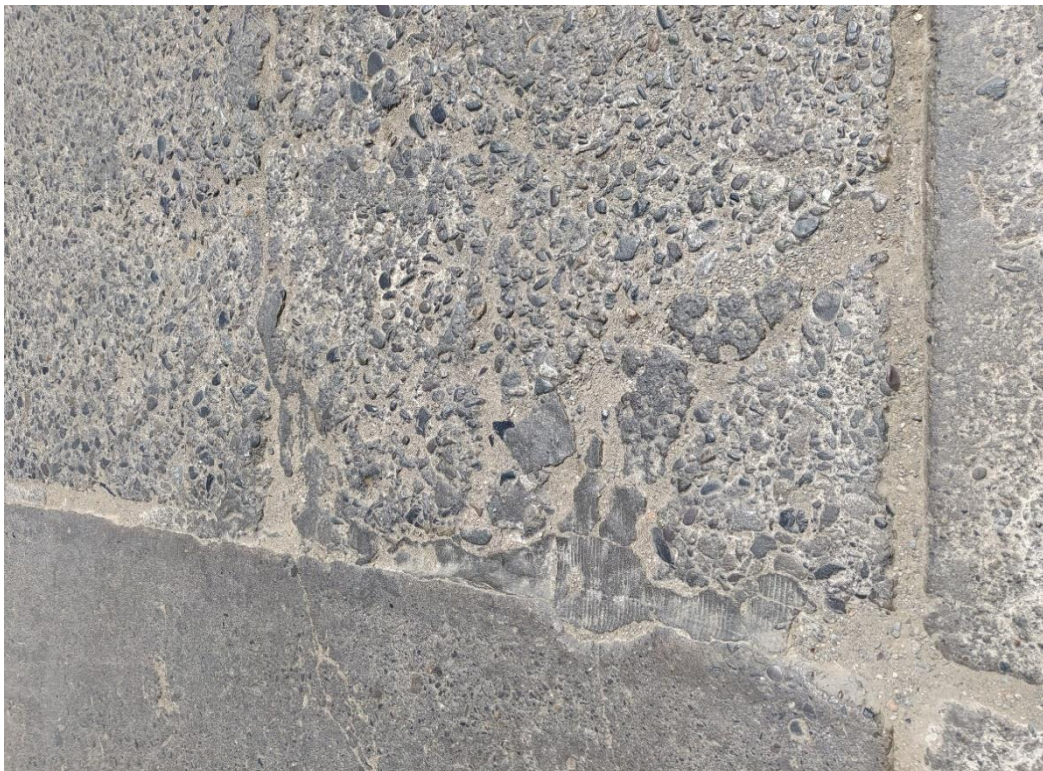
PULIMENTO DE AGREGADOS
