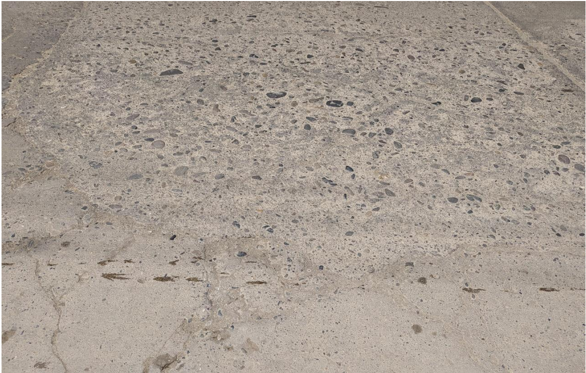
PULIMENTO DE AGREGADOS
