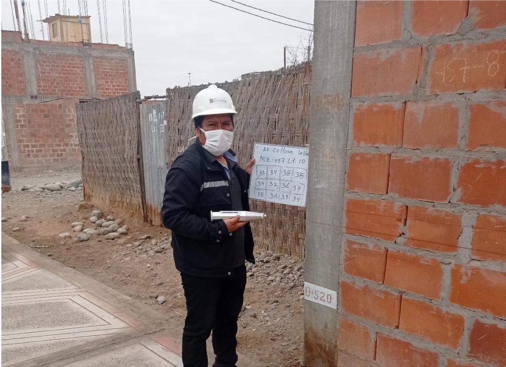
**Fotografía N°19:** Registro de valores emitido por el Esclerómetro.
