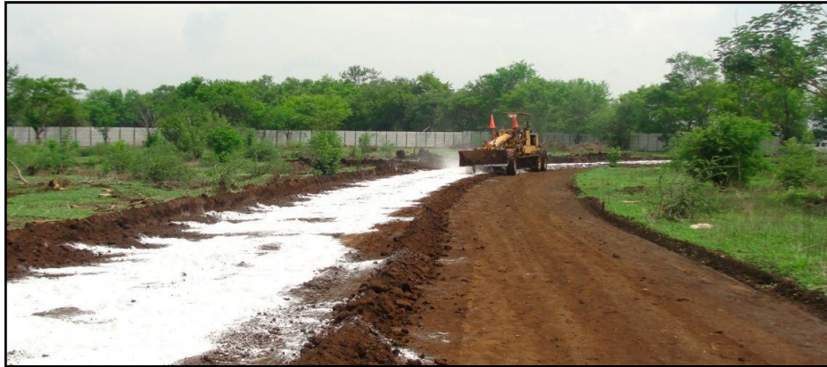
Figura 5. La cal al incorporarse en la base y sub-base.
