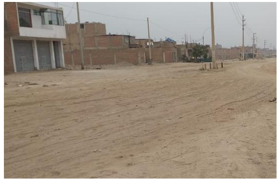
Subrasante de la prolongación José Carlos Mariátegui
