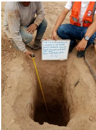
Excavación de la primera calicata con 1.50m de profundidad
