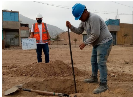
Excavación de la primera calicata con 1.50m de profundidad
