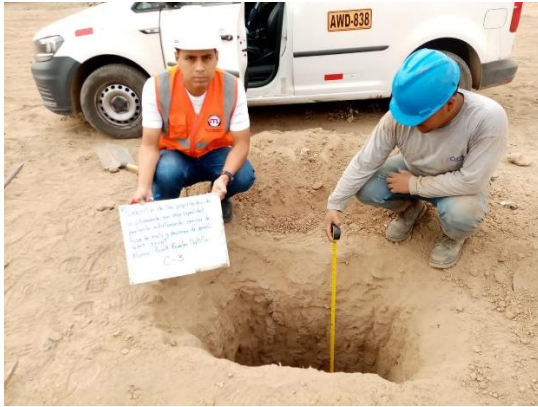
Excavación de la tercera calicata con 1.50m de profundidad
