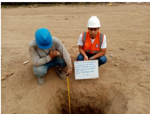
Excavación de la segunda calicata con 1.50m de profundidad
