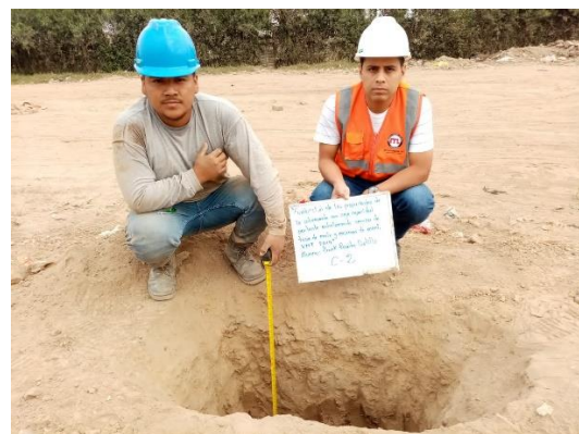
Excavación de la segunda calicata con 1.50m de profundidad
