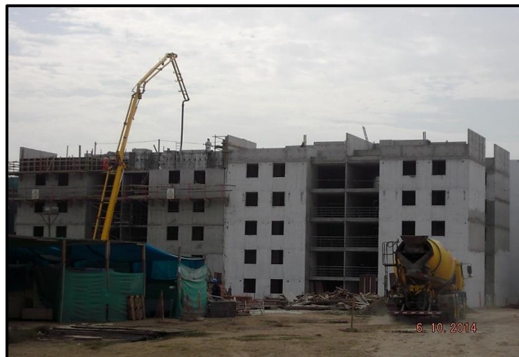
Figura N° 09 Sistema de Estructural - Muros de Ductilidad Limitada
