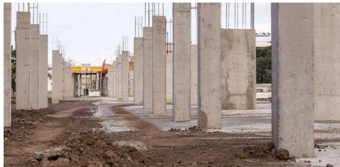
Figura: Columnas de sistema aporticado.
