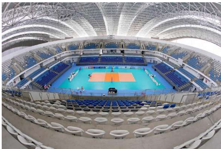
Figura: Cubierta metálica – polideportivo del callao
