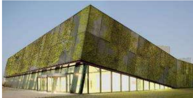
Figura: Sistema hormigón vegetal
