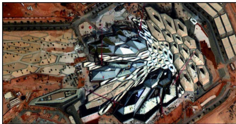
FIGURA 3 PROCESO DE CONSTRUCCIÓN DE KAPSARC
