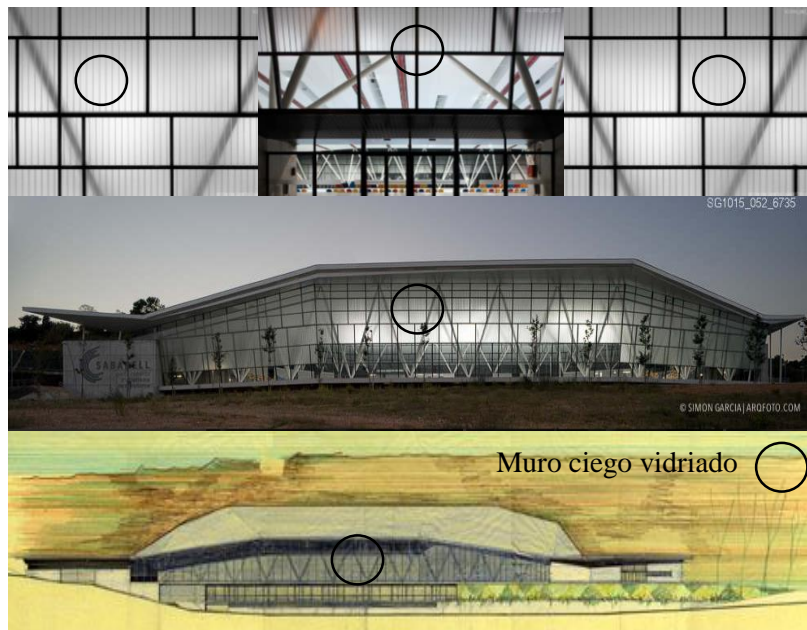
Figura 32. Materialidad de la Pista cubierta de Atletismo de Cataluña
