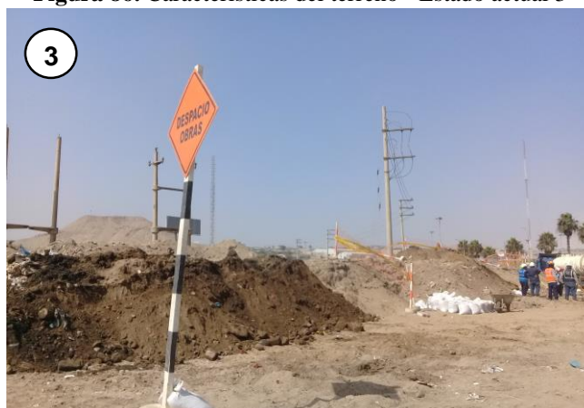
Figura 86. Características del terreno - Estado actual 3
