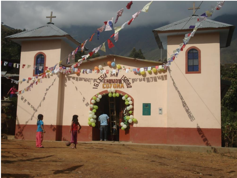
IMAGEN N° 08: IGLESIA SAN ISIDRO DE COYONA
