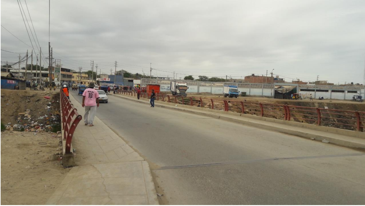
Fotografía 03: Vista del acceso del Puente en dirección Sur.
