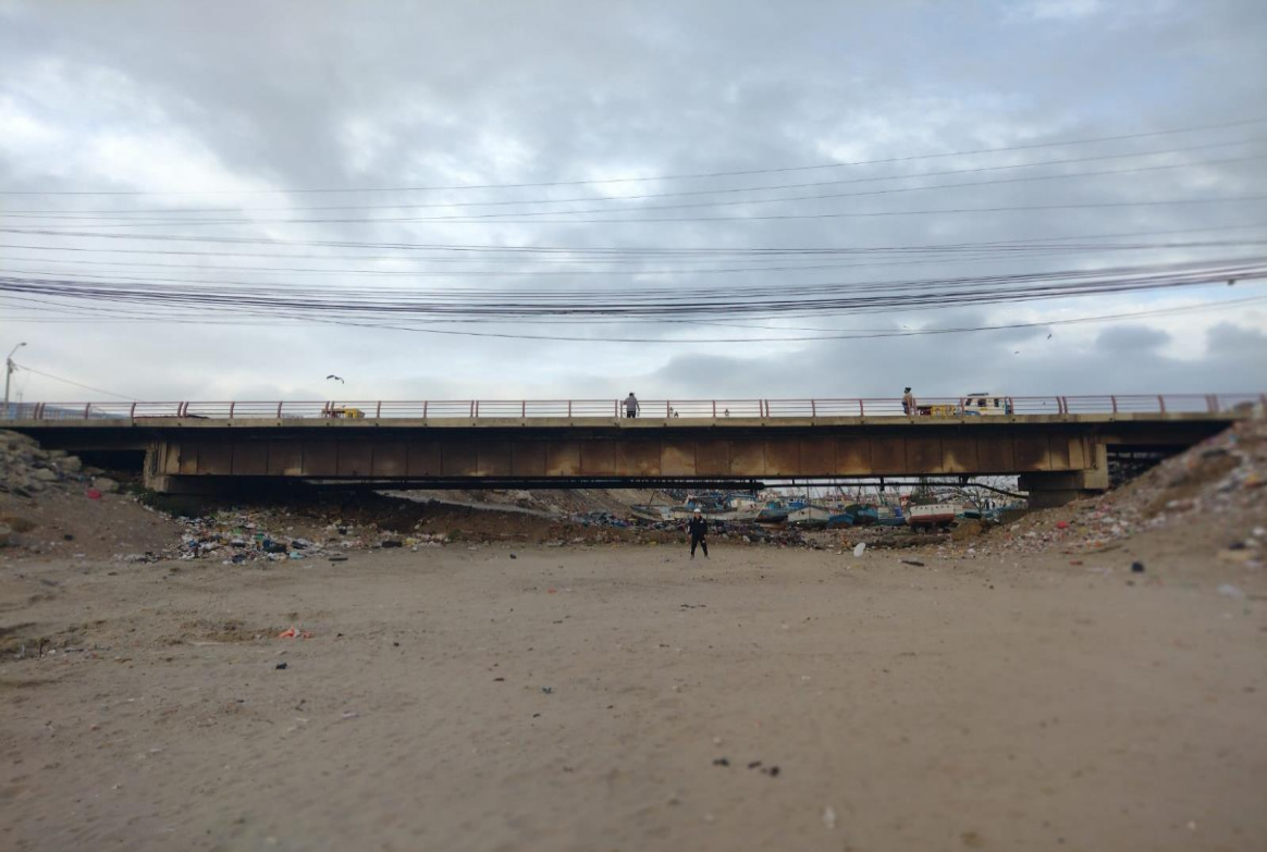
Fotografía 01: Vista panorámica del Puente
