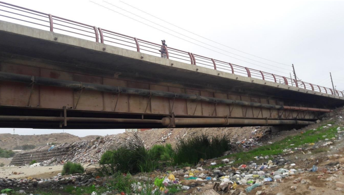
Fotografía 02: Vista de la superestructura del Puente
