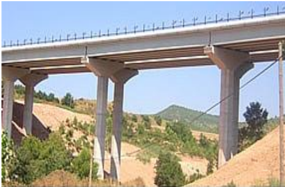
Puente de Viga
