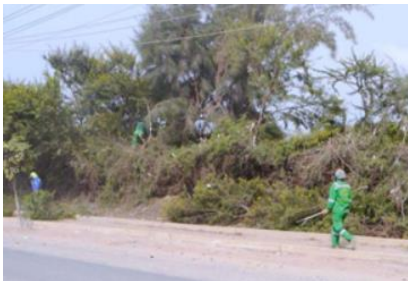
Figura 8: Trabajo de limpieza en la ciclovia de Imperial - San Vicente de Cañete
