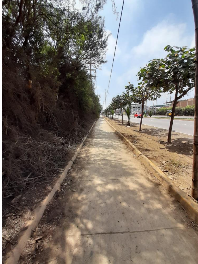
Figura 5: Ciclovía en riesgo de ser interrumpido el pase a ciclistas por los arbustos secos
