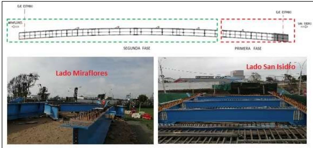
Figura N° 59. Sistema de Montaje In- Situ
