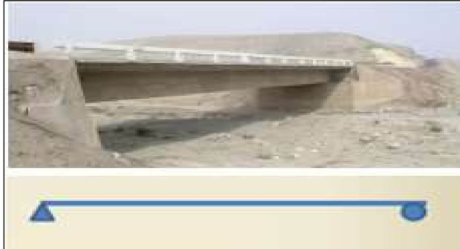
Figura N° 3. Puente Simplemente Apoyado
