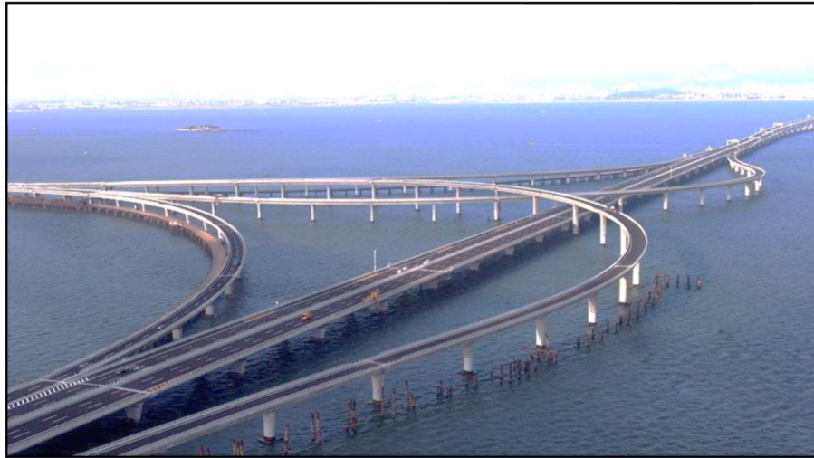
Figura N° 8. Puente Hangzhou Bay
