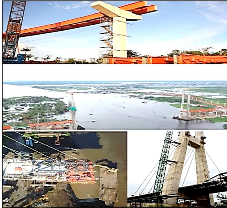
Figura N° 18. Izaje, Montaje y lanzamiento del Puente Nanay
