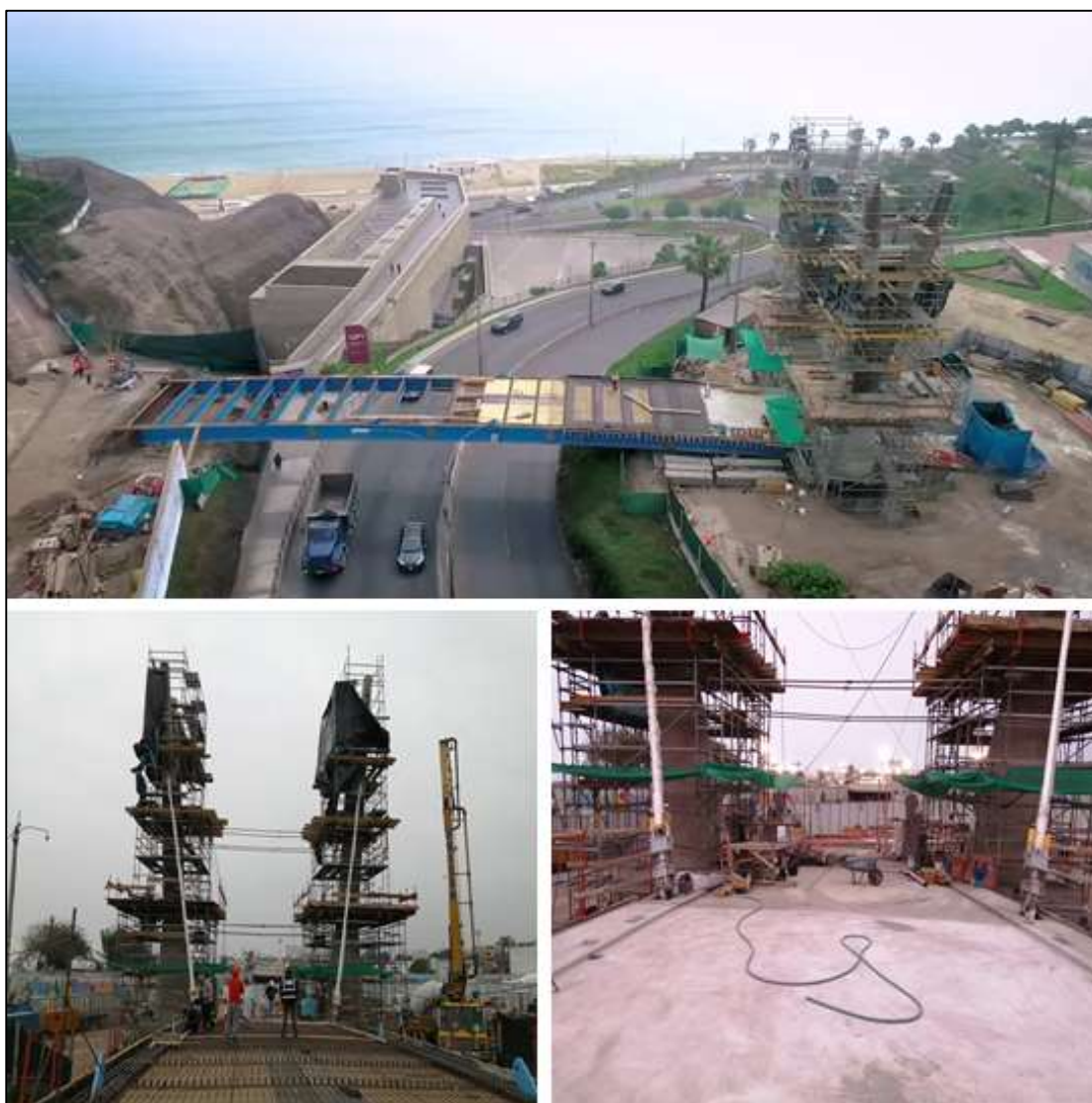
Figura N° 66. Secuencia de Construcción - Tensado de Tirantes
