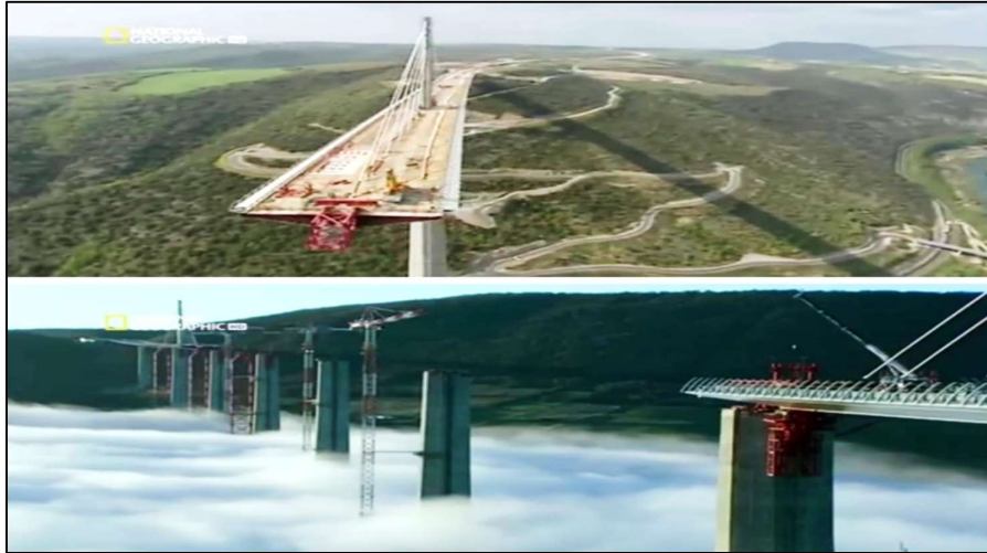
Figura N° 14. Montaje y Lanzamiento del Puente Millau, Francia
