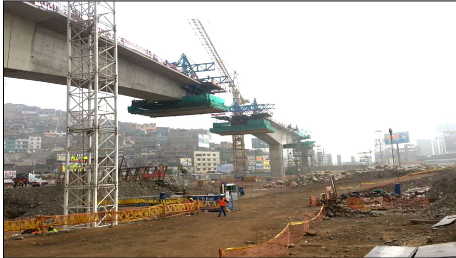
Figura N° 15. Montaje y construcción de tramos de la Línea 1
