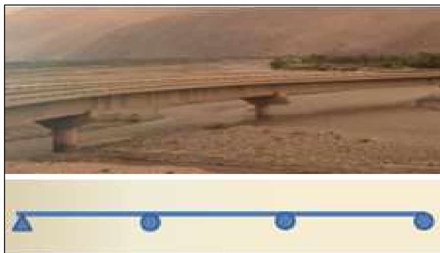
Figura N° 2. Puente con Apoyos Continuos
