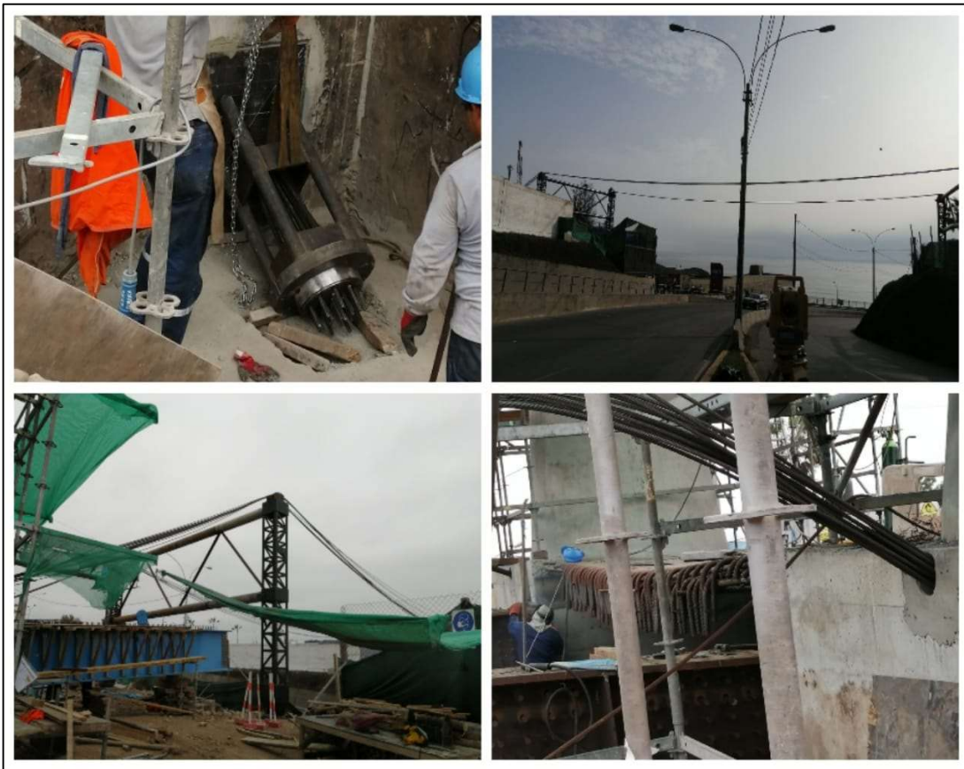
Figura N° 62. Detalle de los Cables para el lanzamiento de las E.M.
