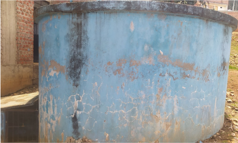
Ilustración 11: Reservorio circular 4.80 m diámetro x 4.30 m.
