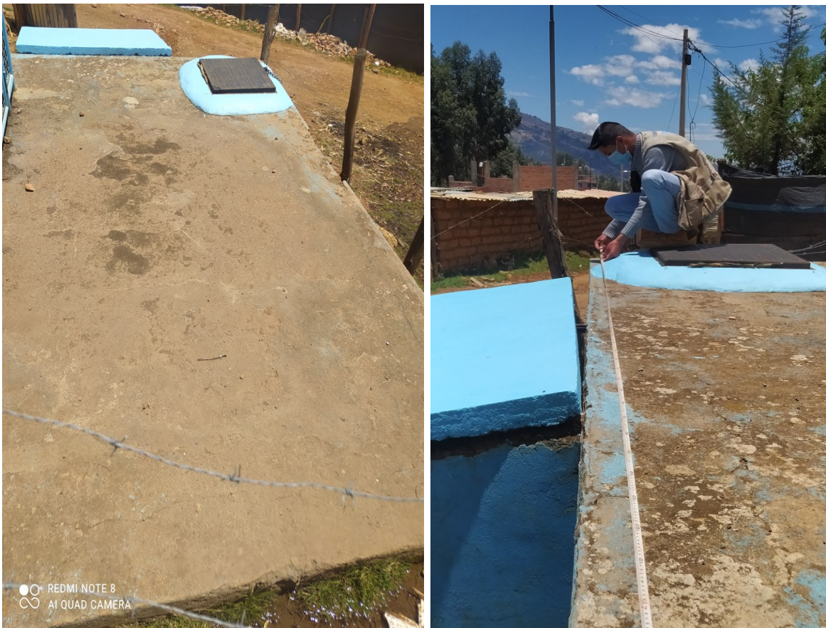
Ilustración 7: Captación de tipo filtración N° 3 tubería PVC 4”.
