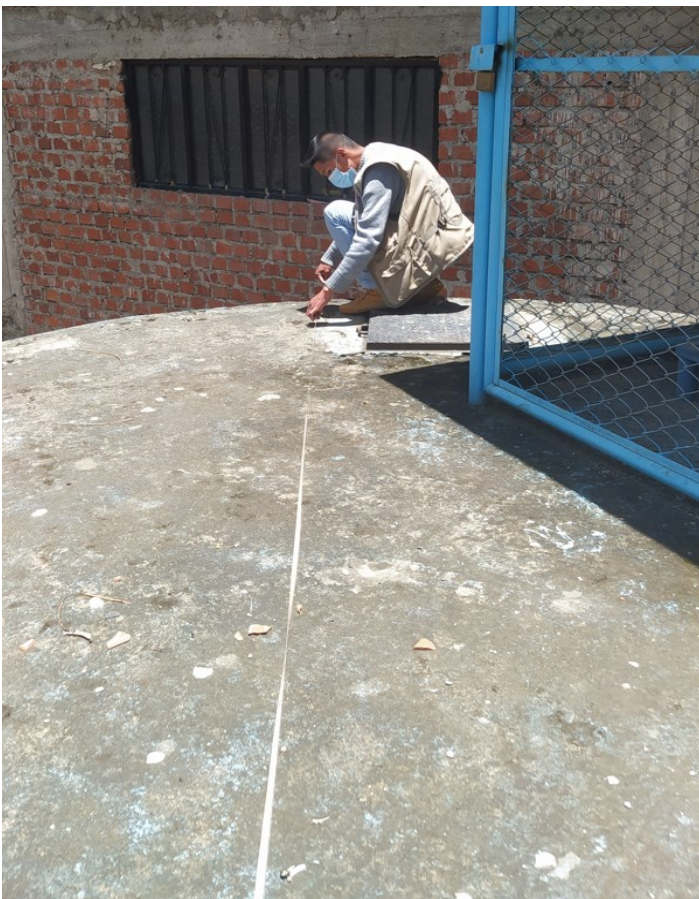
Ilustración 11: Reservorio circular 4.80 m diámetro x 4.30 m.
