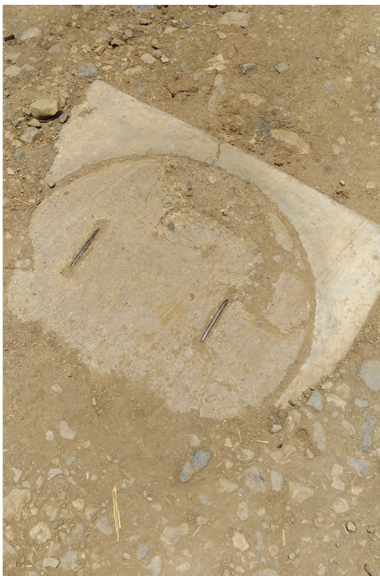
Ilustración 15: Buzón 0.90x0.90m
