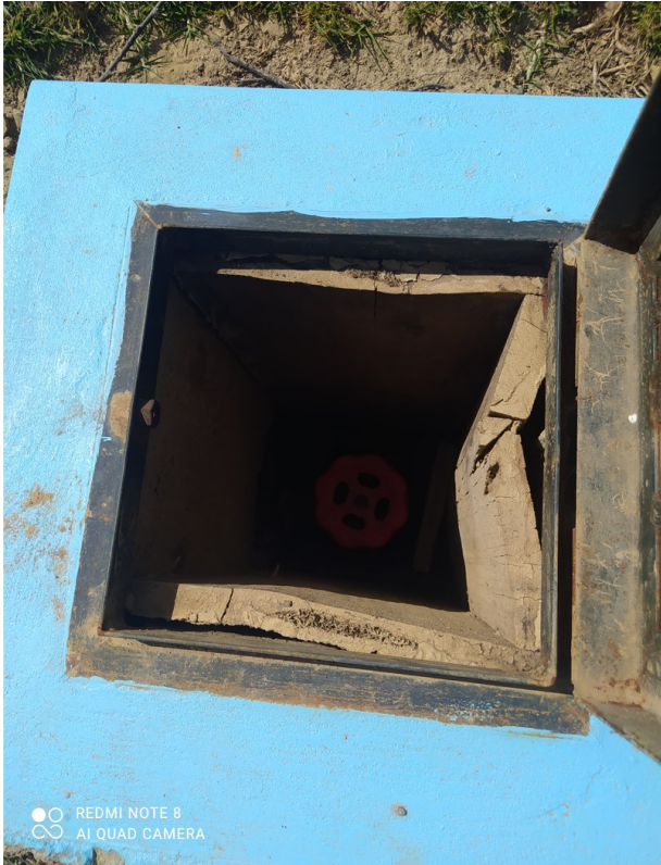
Ilustración 3: Válvula de control de la cámara rompe presión CRP6.
