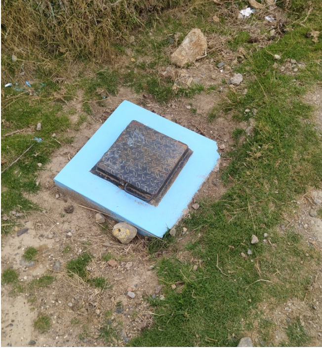
Ilustración 5: Captación de tipo filtración N° 1 tubería PVC 4".
