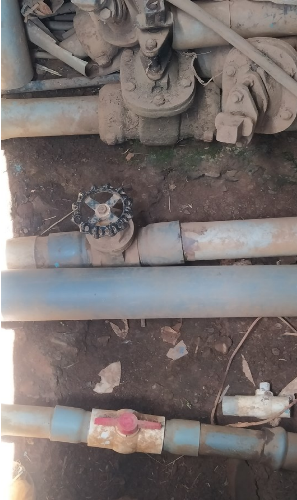
Ilustración 9: Válvula de control 4", válvula de purga 4" y llave de control 2".
