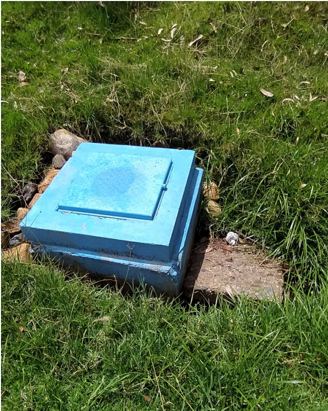
Ilustración 5: Captación de tipo filtración N° 1 tubería PVC 4".
