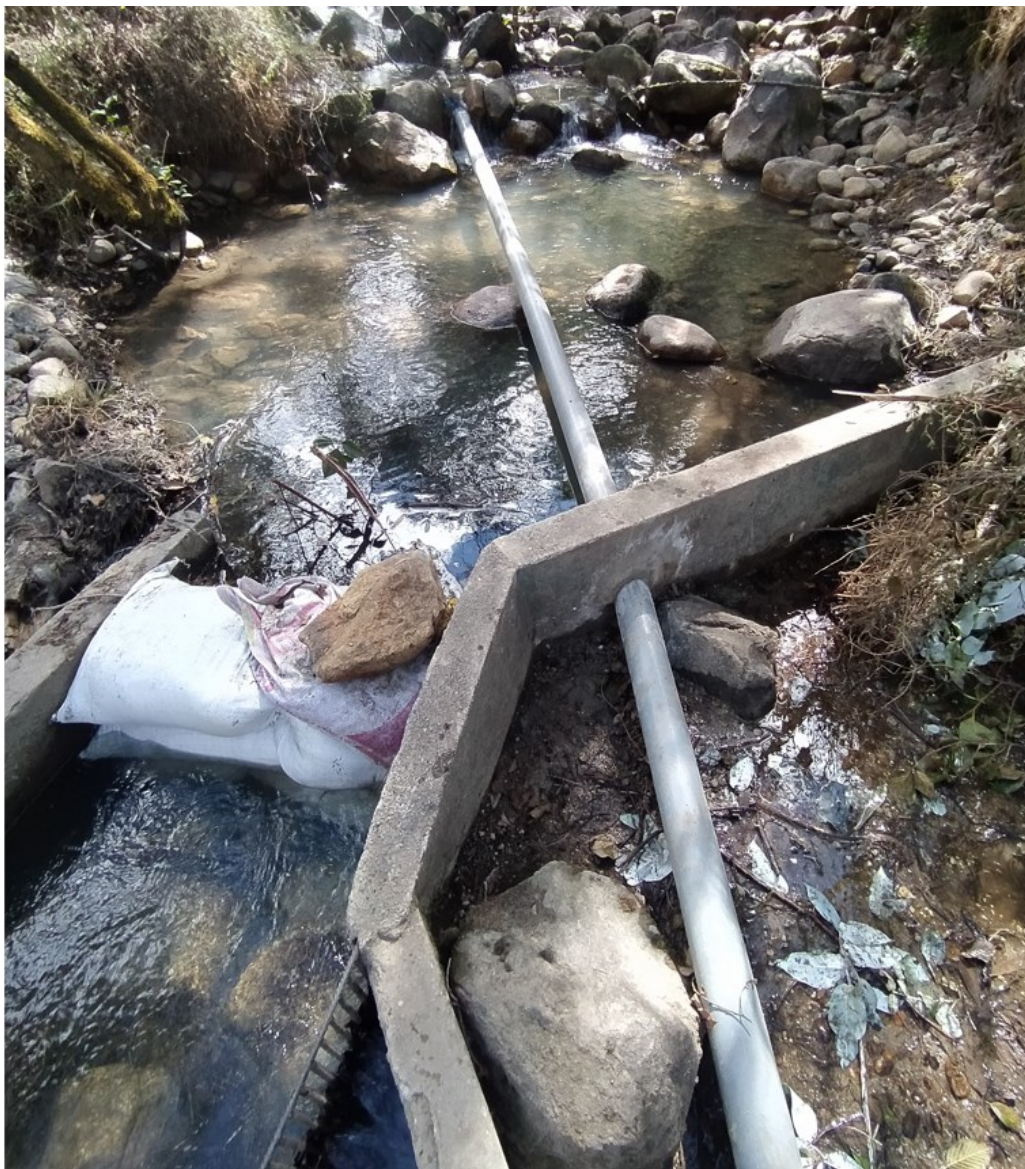
Ilustración 1: Captación de Shirapampa de tipo barraje lateral.
