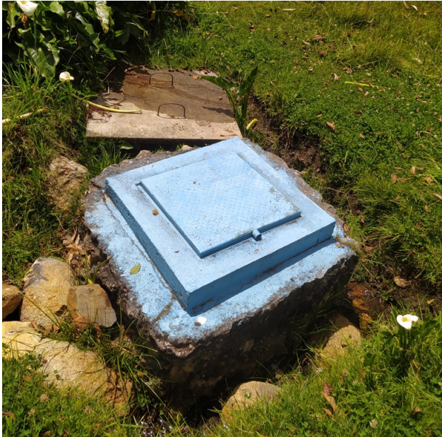
Ilustración 7: Captación de tipo filtración N° 3 tubería PVC 4”.
