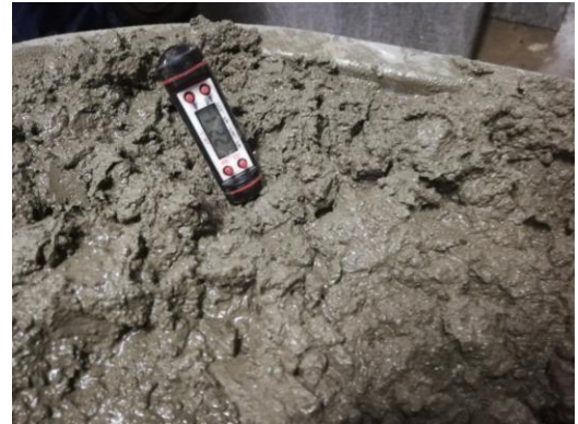
Imagen 12: Medicion de la Temperatura del Concreto
