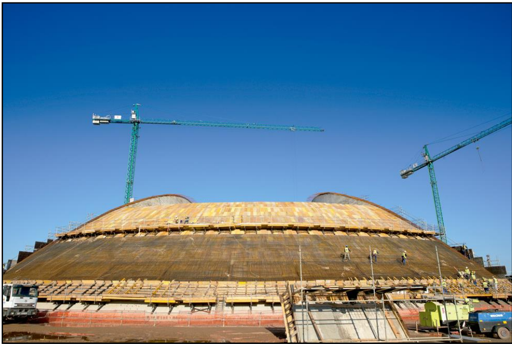
Figura 28 Imagen del método constructivo de los bloques
