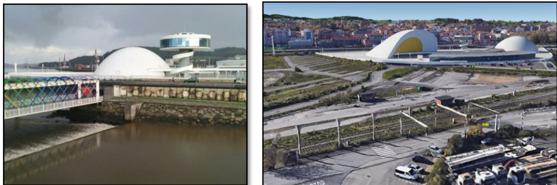
Figura 23 Puente peatonal y estacionamiento del centro cultural
