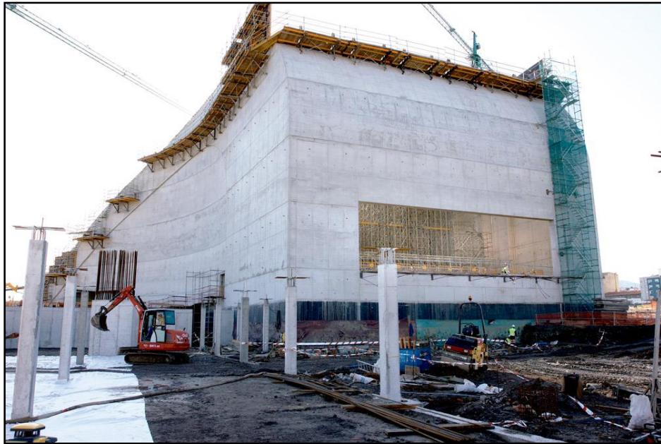
Figura 30 Construcción del auditorio
