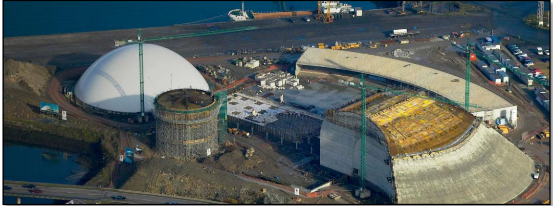
Figura 27 Imagen del método constructivo de los bloques
