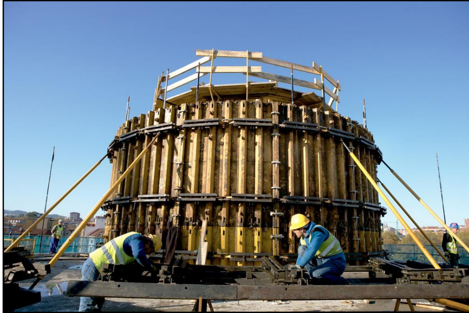
Figura 29 Material de construcción
