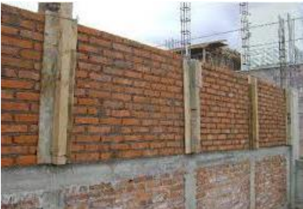
Figura 74 Muro de ladrillo en soga Fuente: Universidad Andina del Cusco
