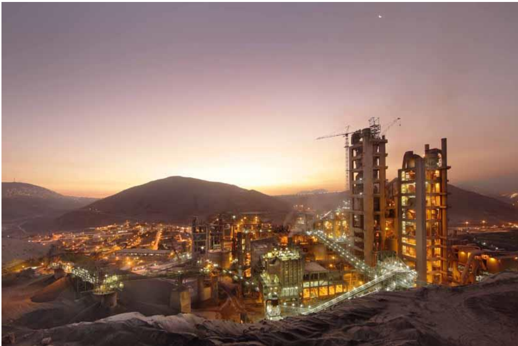
Figura 48 Planta concretera UNACEM Fuente: UNACEM
