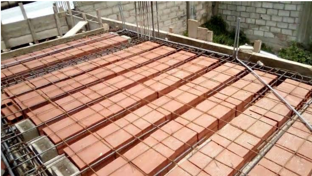
Figura 73 Losa aligerada Fuente: Libre Ingeniería Civil
