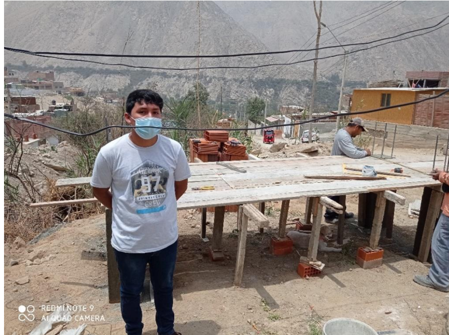
Figura 21: Encofrado de los paños de prueba 1.
