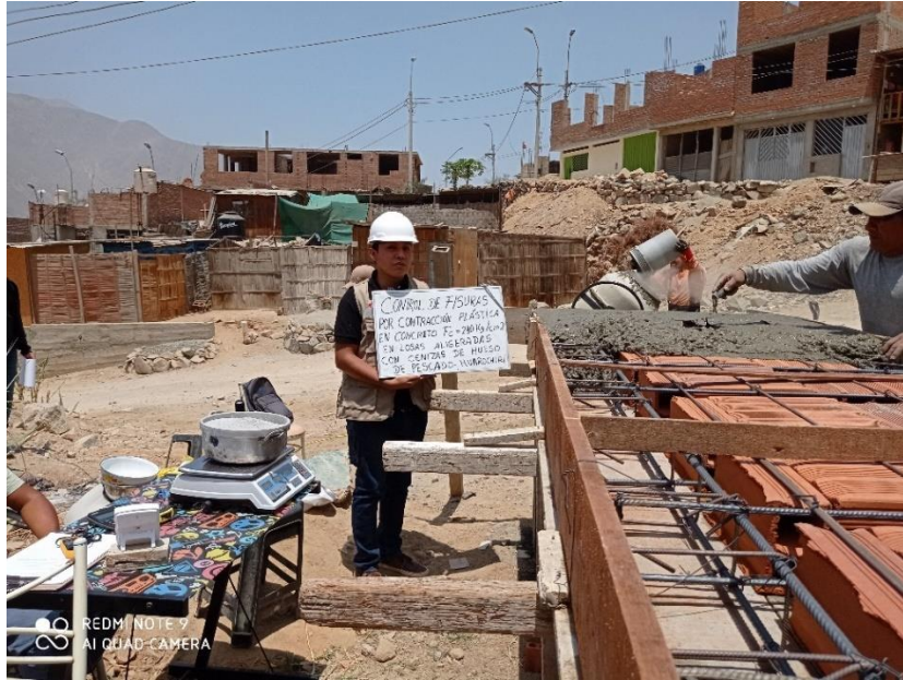
Figura 23: Vaciado de concreto de losa aligerada de los paños de prueba 1.
