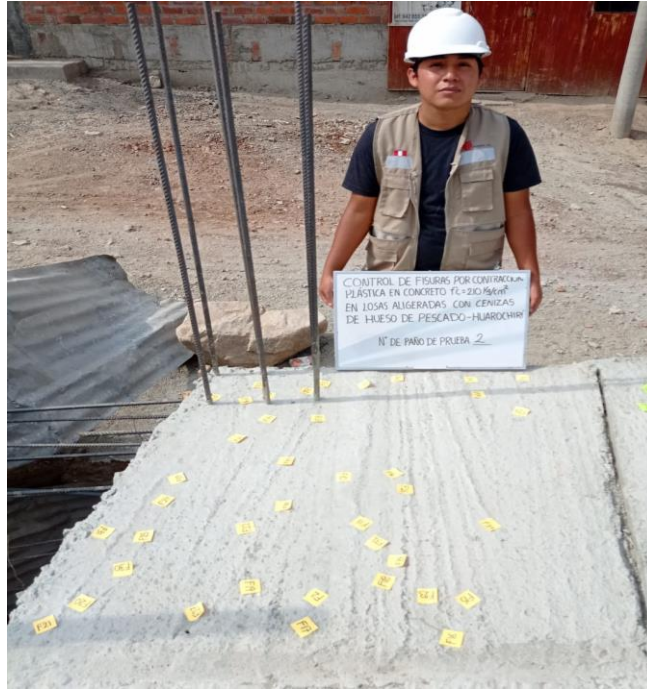
Figura 39: Losa aligerada patrón (Paño de prueba 2).
