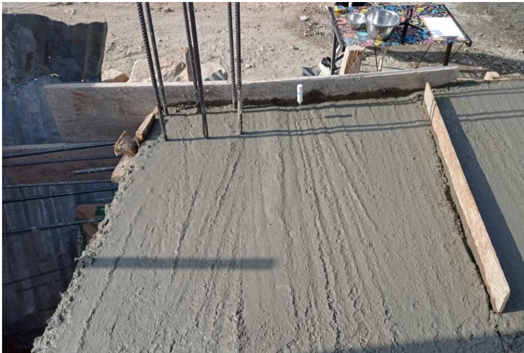
Figura 27: Vaciado culminado de concreto de losa aligerada patrón de los paños de prueba 2.
