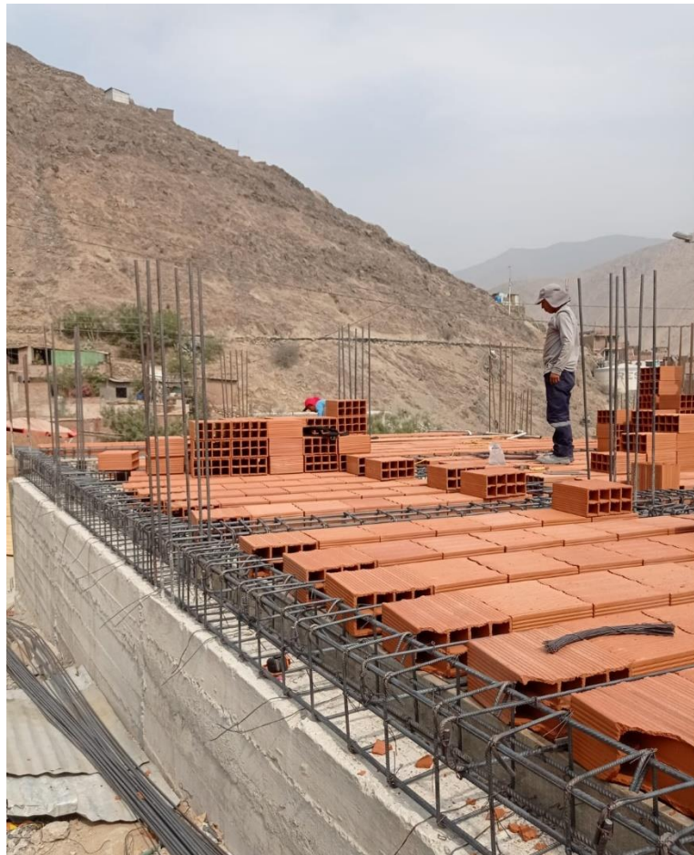
Figura 25: Distribución de ladrillo de techo y colocado de acero.
