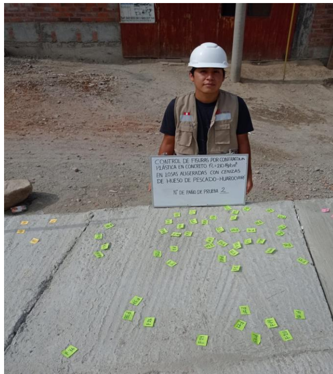
Figura 40: Losa aligerada con 3% de ceniza de hueso de pescado (Paño de prueba 2).
