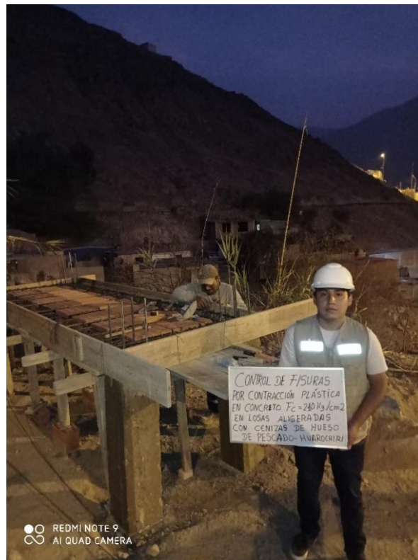
Figura 22: Armado, colocado de acero y colocado de ladrillo de techo de los paños de prueba 1.
