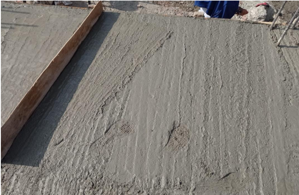
Figura 29: Vaciado culminado de concreto de losa aligerada con 6% de CHP de los paños de prueba 2.
