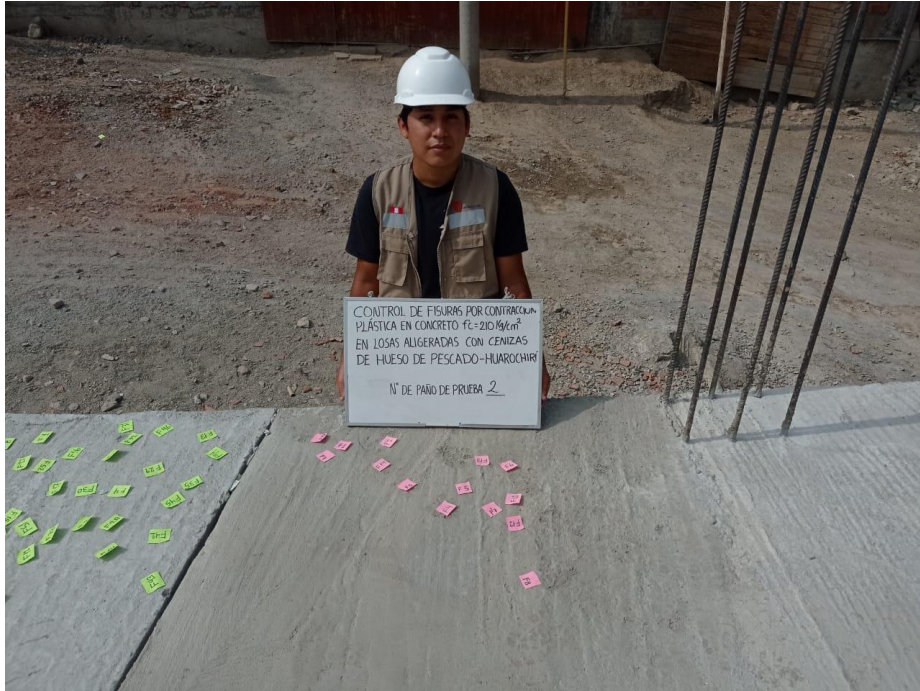
Figura 41: Losa aligerada con 6% de ceniza de hueso de pescado (Paño de prueba 2).
