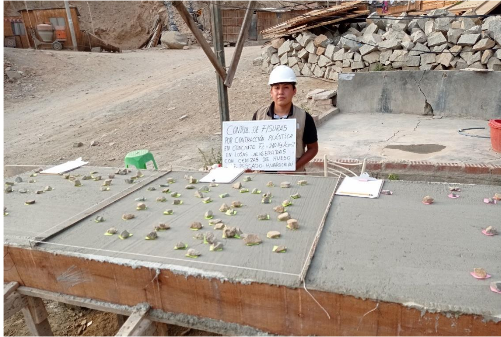
Figura 31: Losas aligeradas de los paños de prueba 1.
