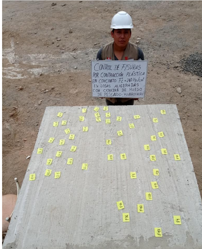
Figura 33: Losa aligerada patrón (Paño de prueba 1).
