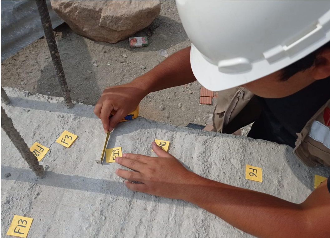
Figura 43: Medición de la longitud de las fisuras de los paños de prueba 2 con el flexómetro.
