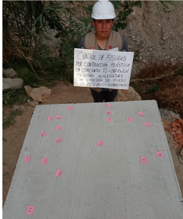
Figura 35: Losa aligerada con 6% de ceniza de hueso de pescado (Paño de prueba 1).
