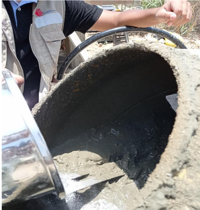
Figura 26: Preparación del concreto con la mezcladora de los paños de prueba 2.
