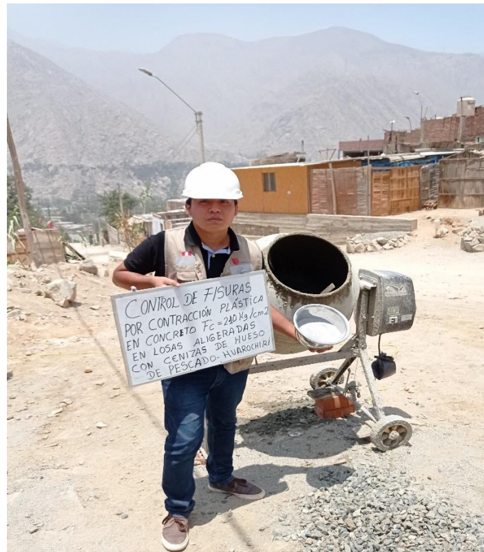
Figura 24: Mezcla de concreto con adición de ceniza de hueso de pescado de los paños de prueba 1.
