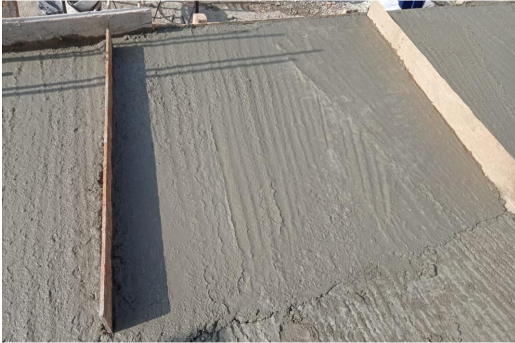
Figura 28: Vaciado culminado de concreto de losa aligerada con 3% de CHP de los paños de prueba 2.
