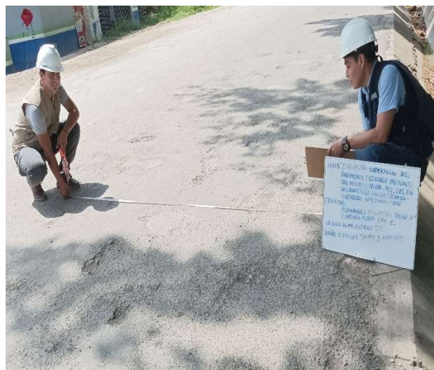
Figura 27. Identificación de fallas mediante el método PCI
