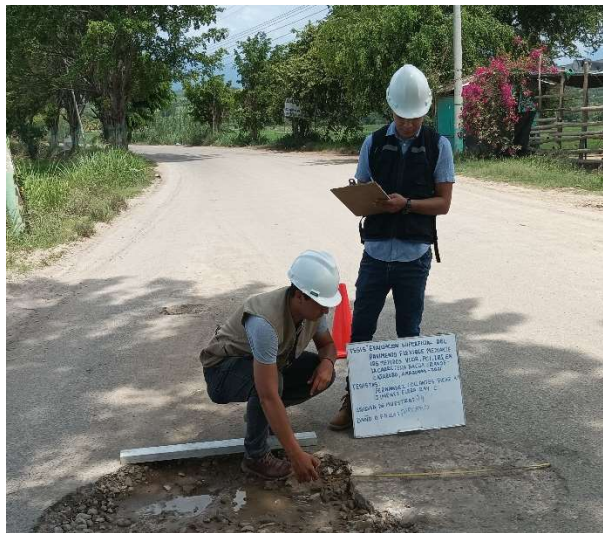
Figura 23. Identificación de fallas mediante el método PCI
