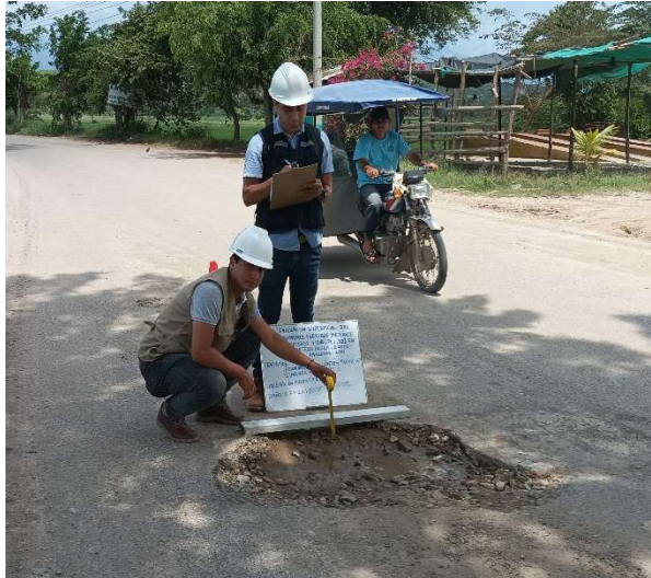
Figura 22. Identificación de fallas mediante el método PCI
