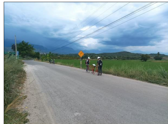
Figura 8. Realización de ensayo con rugosímetro de Merlin, carril izquierdo, lado derecho.
