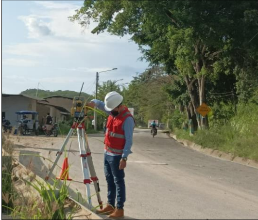
Figura 1. Posicionamiento de estación total
