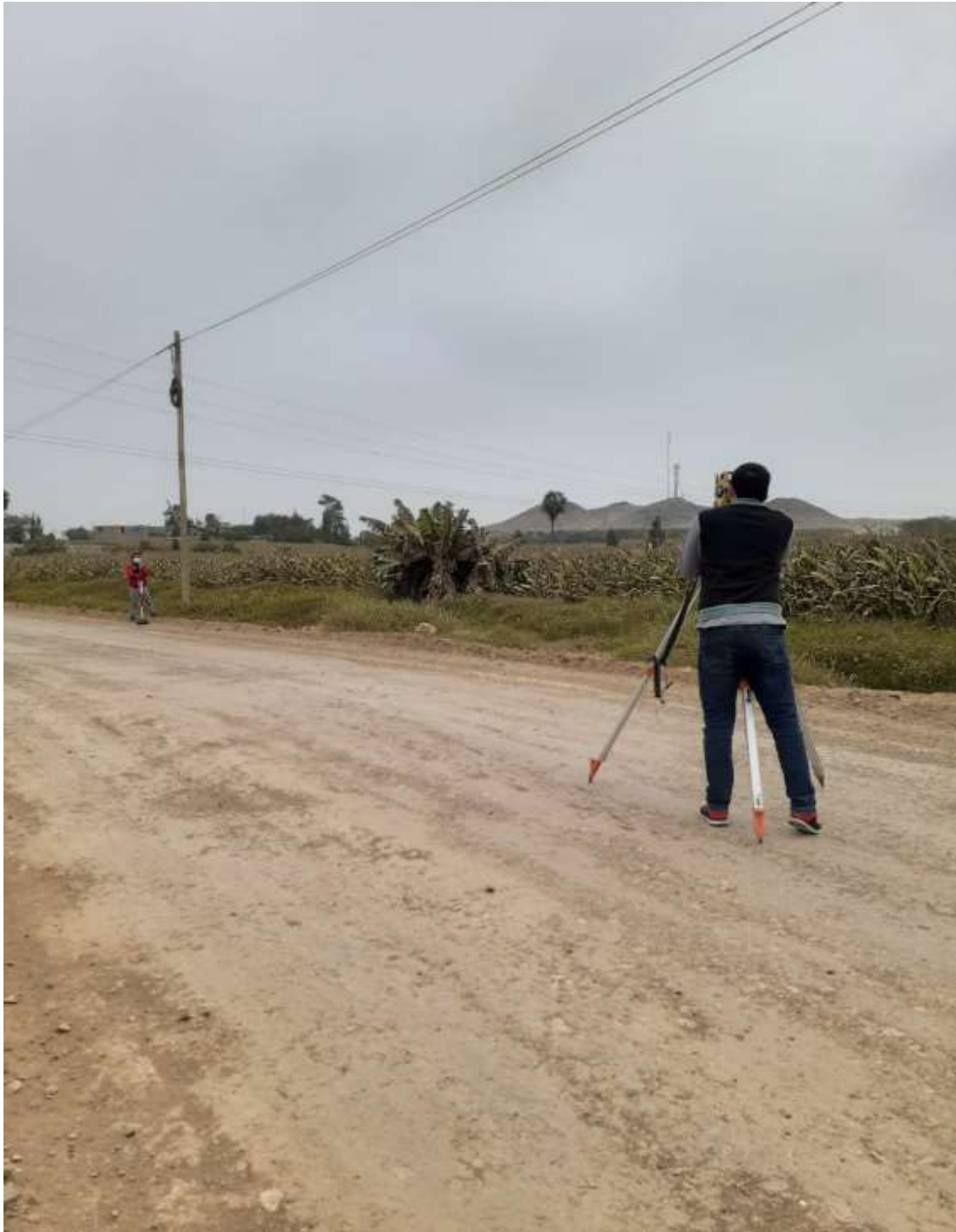
Levantamiento topográfico Punto de estación N°01
