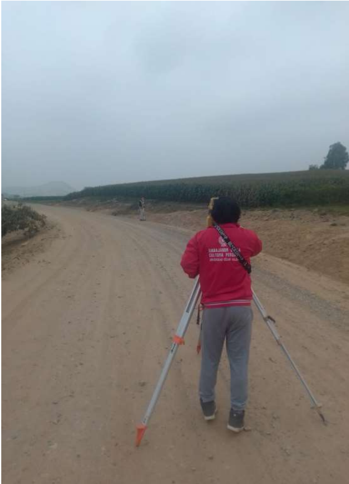
Levantamiento topográfico con estación total.
