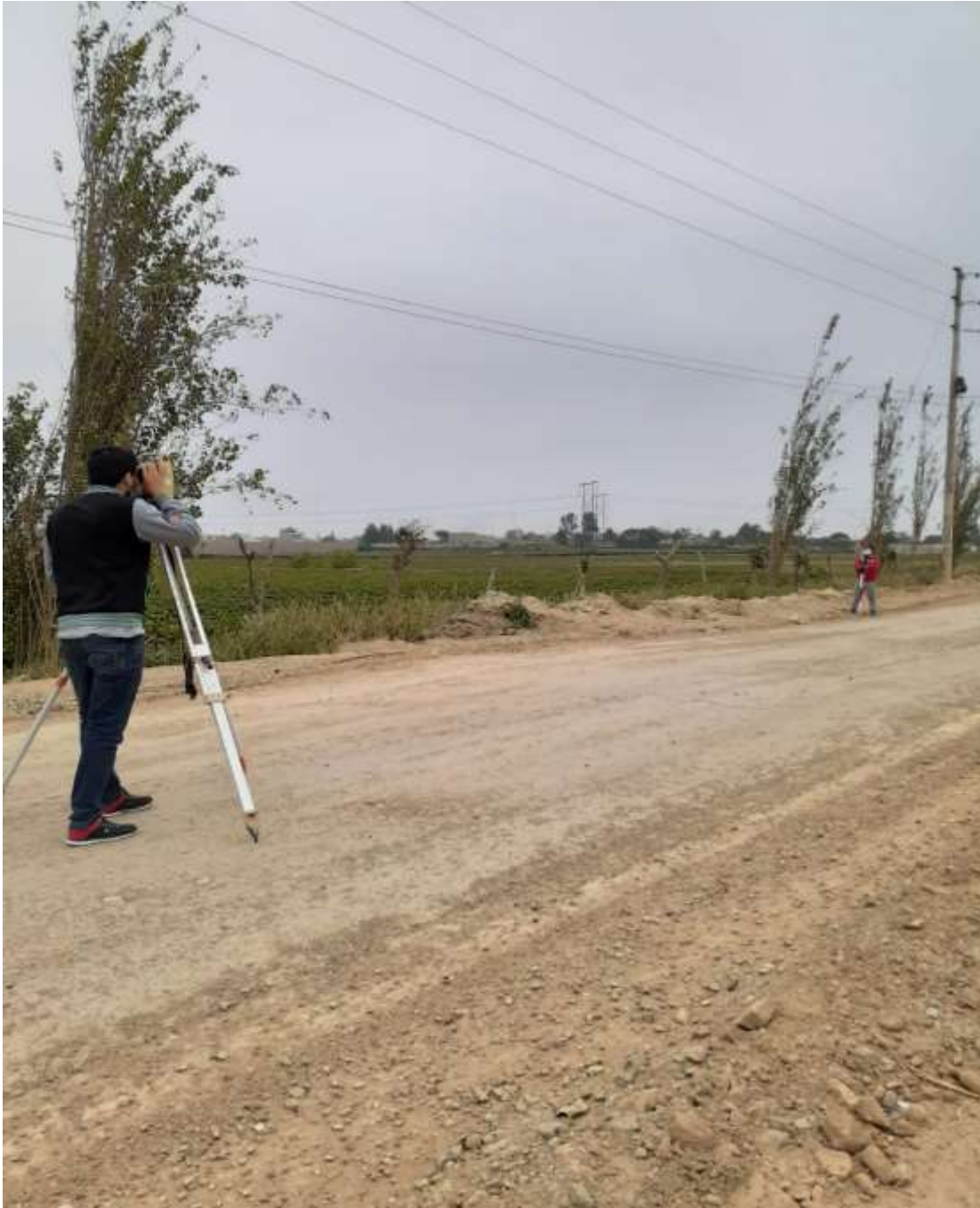
Levantamiento topográfico con estación total
