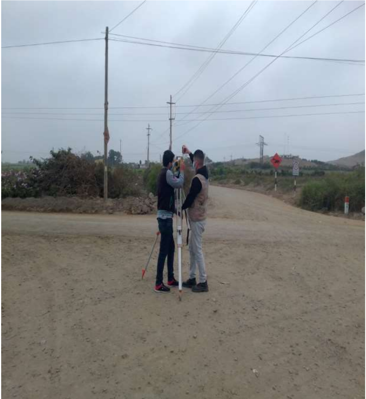
Medición con la wincha de la estación total.
