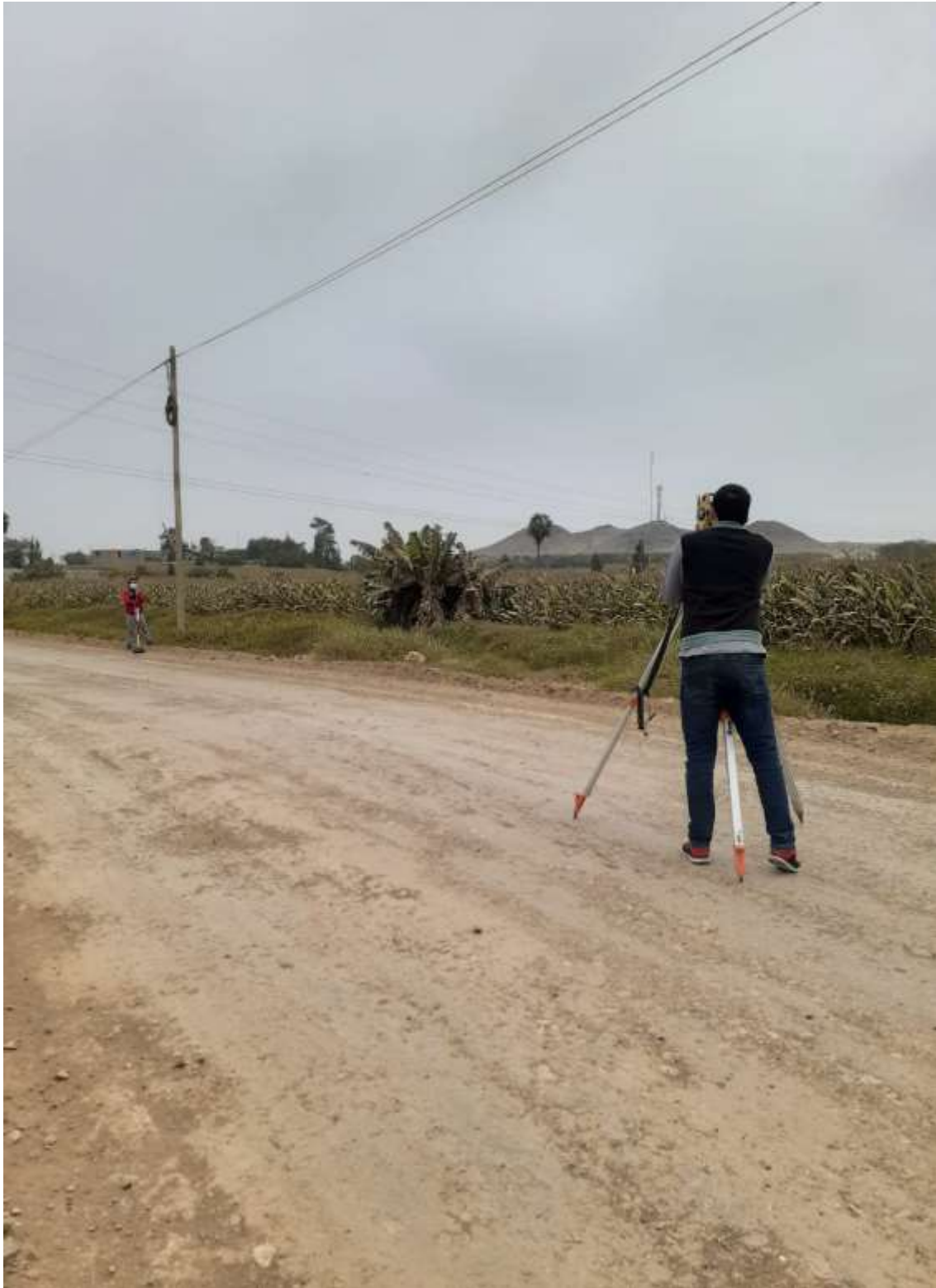
Levantamiento topográfico con estación total
