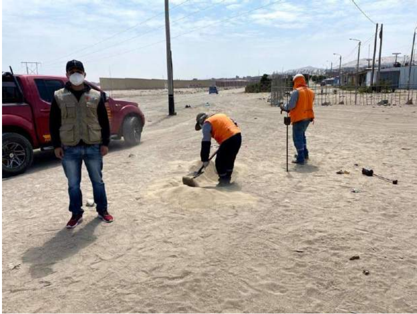
Excavación de calicata N° 1
