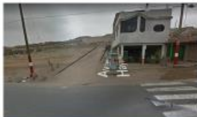
CALLE PROLONGACION AREQUIPA: ESTA CALLE SE ENCUENTRA SIN ASFALTAR, NO HAY VEREDAS NI PISTAS, MAS AUN ASI LOS VEHICULOS PARTICULARES Y DE TRANSPORTE PUBLICO TRANSITAN POR ESTA CALLE.
