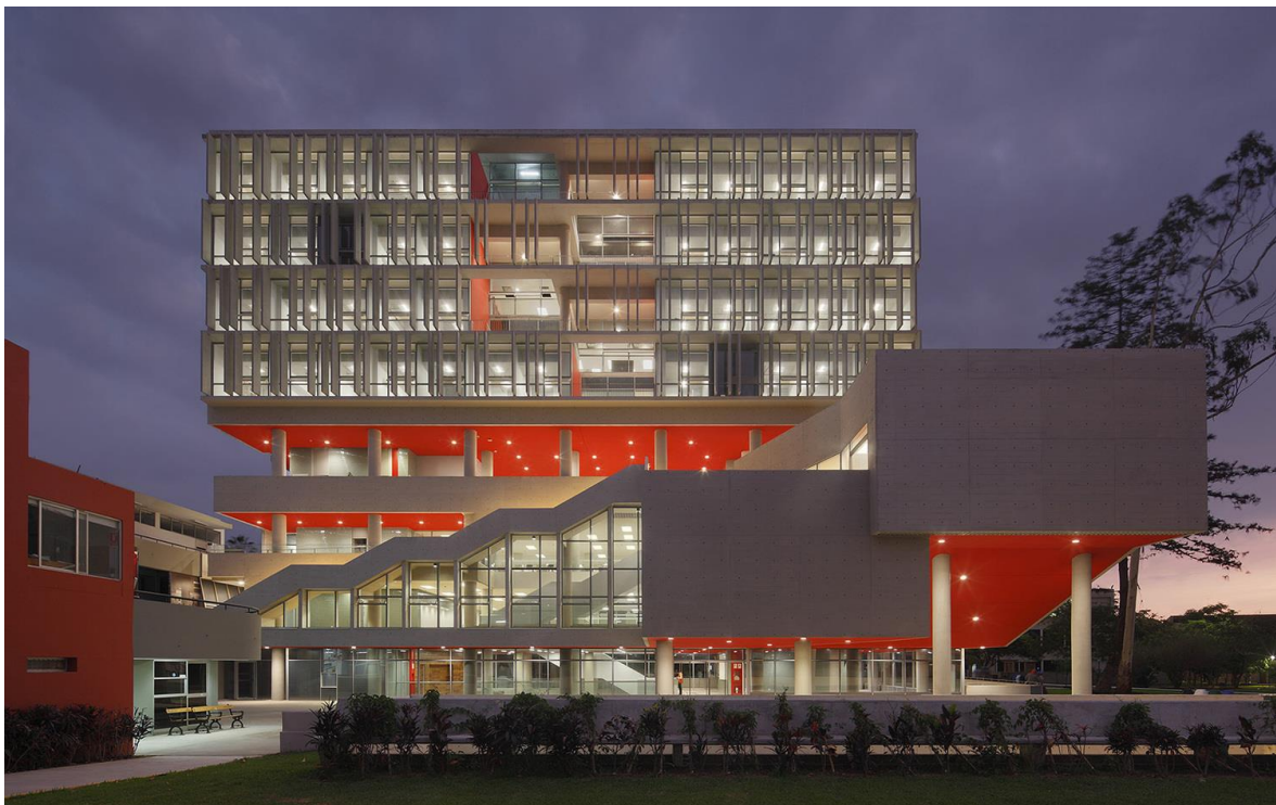
Gráfico 3 Fachada principal del Nuevo pabellón Ciencias Sociales PUCP. Fotografía de Juan Solano Ojasí.
