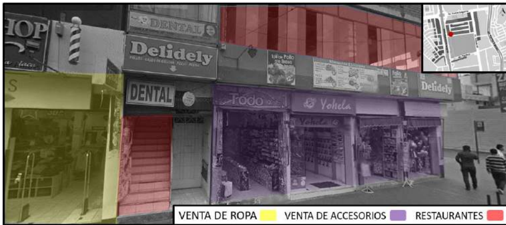
FUENTE: Street view de la Calle 1 (Google Maps, 2015)
