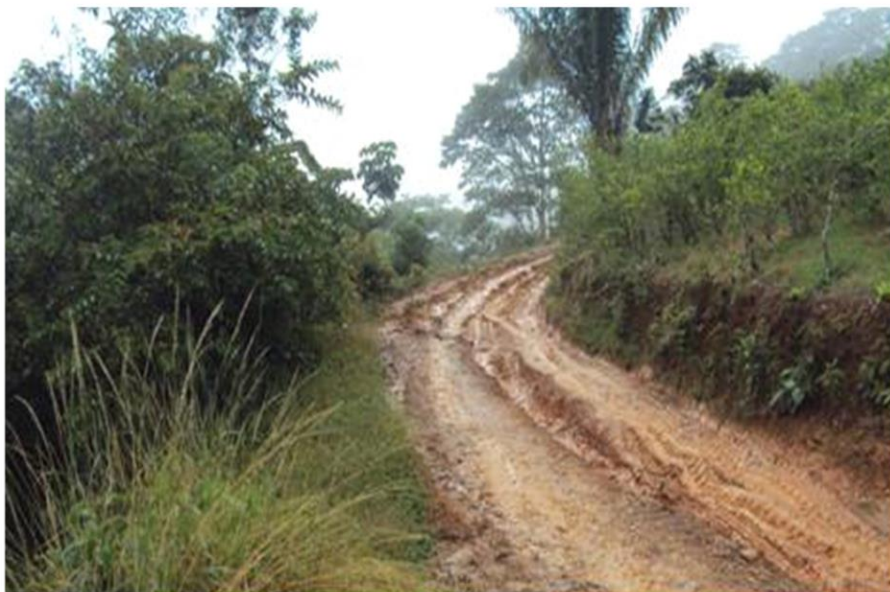
Carretera no pavimentada de Aurora Alta – Arizona Km 0+500.
