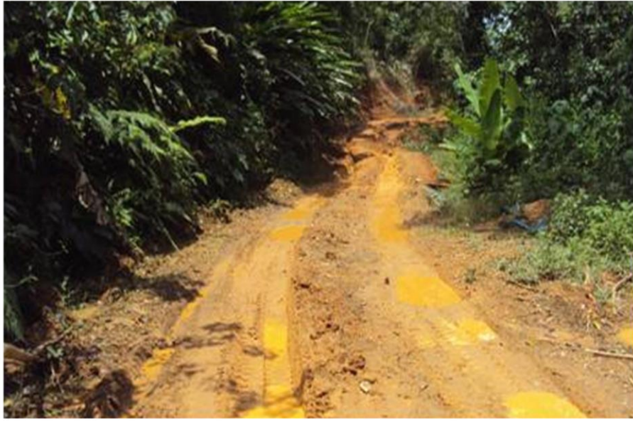
Carretera no pavimentada de Aurora Alta – Arizona Km 0+700.
