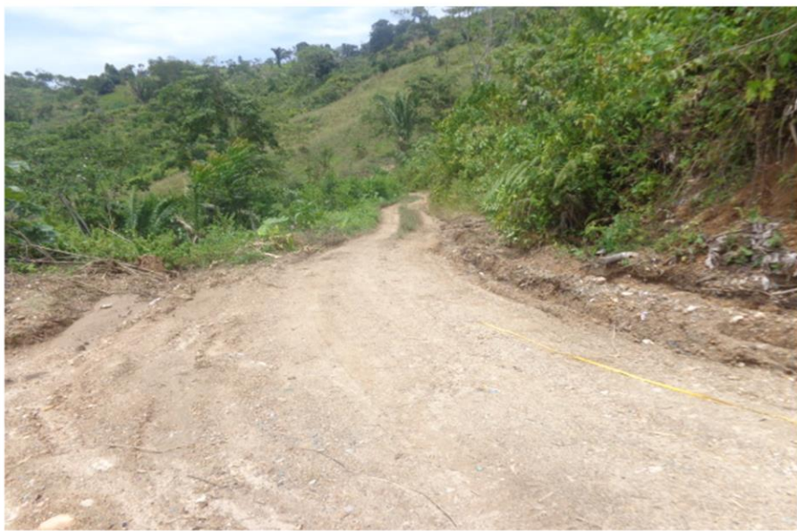
Carretera no pavimentada de Aurora Alta – Arizona Km 1+000.
