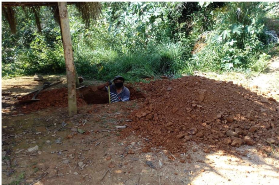
Calicata 02 (C-2) en el KM 2+000, tramo Aurora Alta – Arizona.
