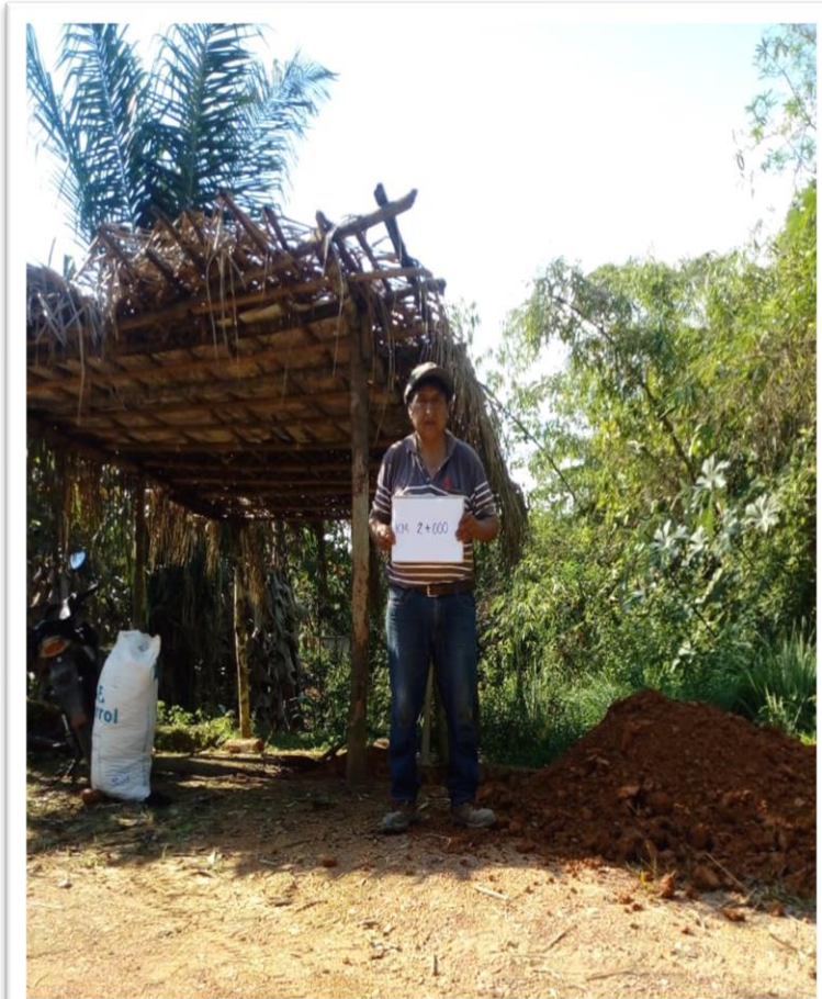
Calicata 02 (C-2) en el KM 2+000, tramo Aurora Alta – Arizona.
