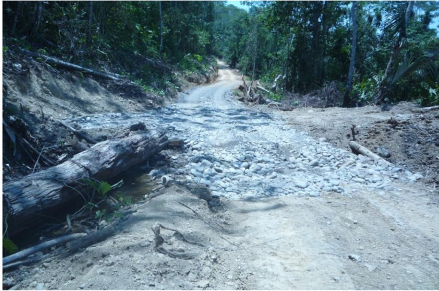
Carretera no pavimentada de Aurora Alta – Arizona Km 0+200.
