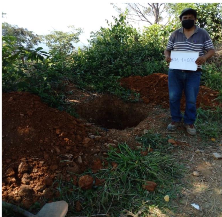
Calicata 01 (C-1) en el KM 1+000, tramo Aurora Alta – Arizona.
