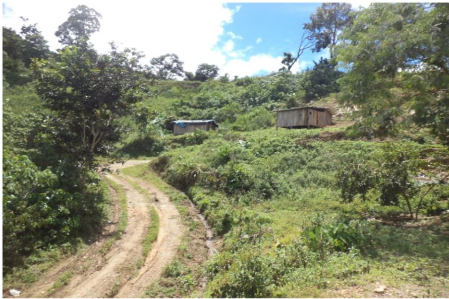
Carretera no pavimentada de Aurora Alta – Arizona Km 2+000.
