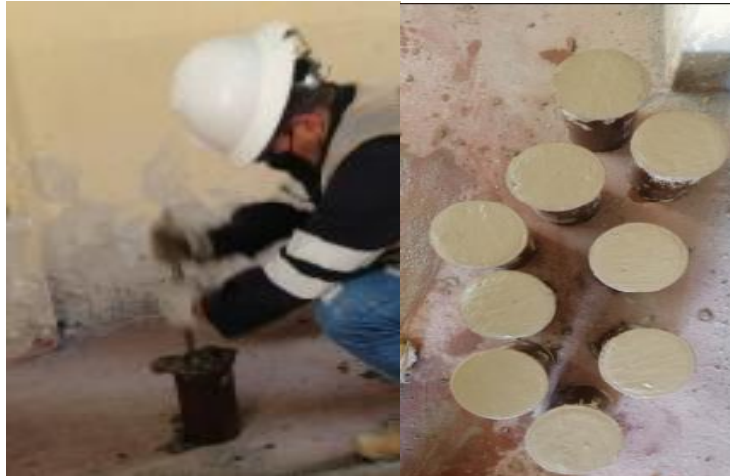
Figura 44. Elaboración de testigos de concreto
