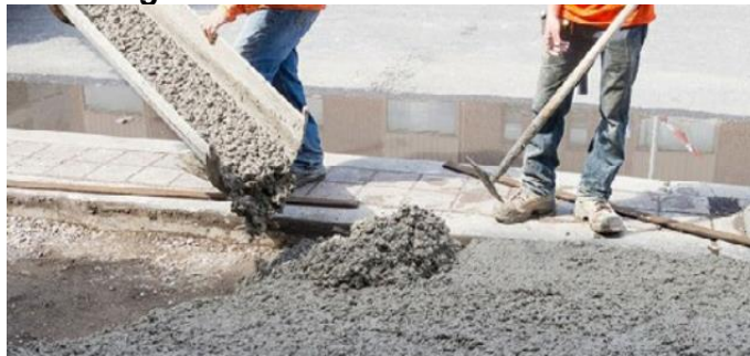
Figura 10. Estado fresco del concreto
