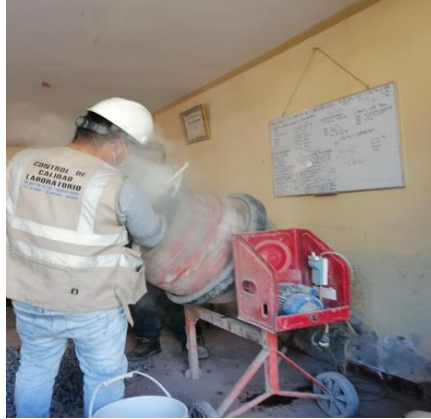
Figura 37. Preparación del concreto
