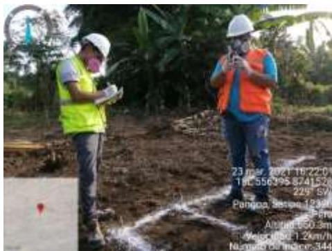
Fuente: Elaboración propia Figura N° 56: Toma de coordenadas UTM del lugar de Pangoa, Mazamari.
