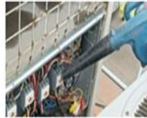
Se implento soplador para limpieza de polvo que tiene las conexiones eléctricas por estar expuesto al medio ambiente
