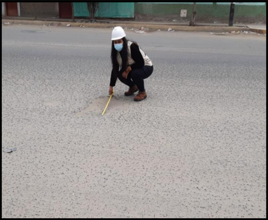
Evaluación de fallas existentes en el pavimento flexible
