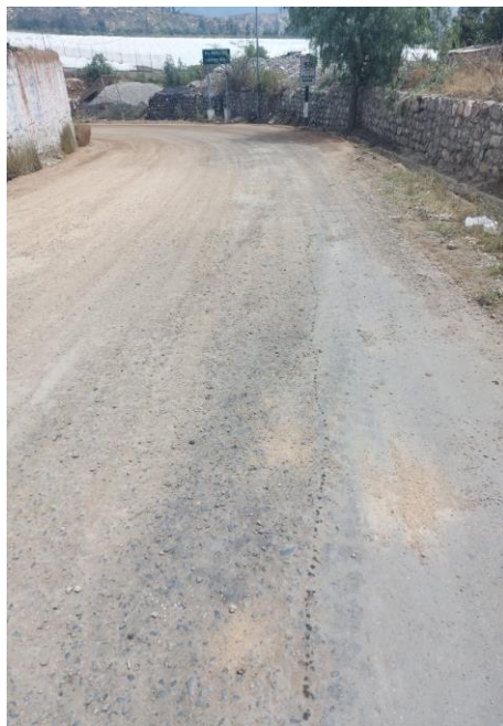
Existe desprendimiento de agregados en la vía
