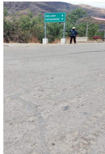
Vía con daños-fallas de fisuramiento longitudinal y/o transversal
