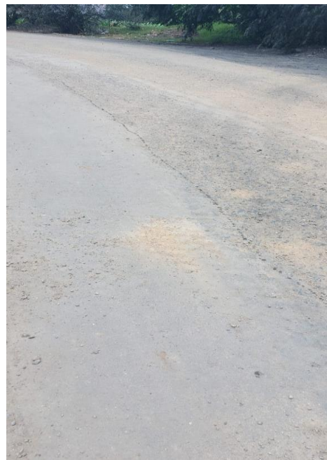
Existe desprendimiento de agregados en la vía
