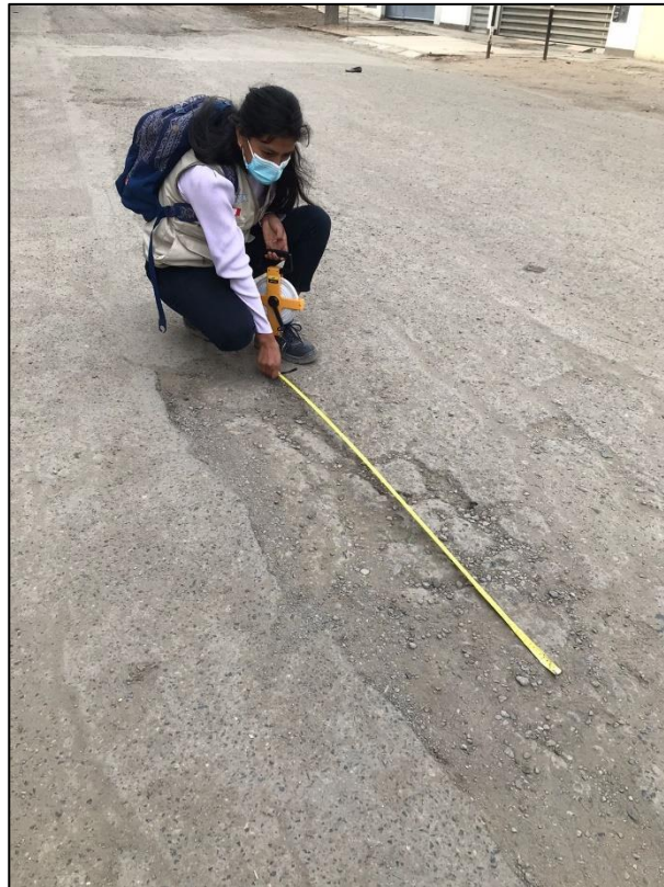
Fotografía 26. Estudio de la Condición del Pavimento
