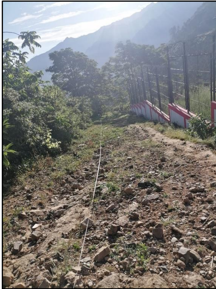
Figura 1. Calle sin pavimentar Rafael Plenchen - segundo tramo
