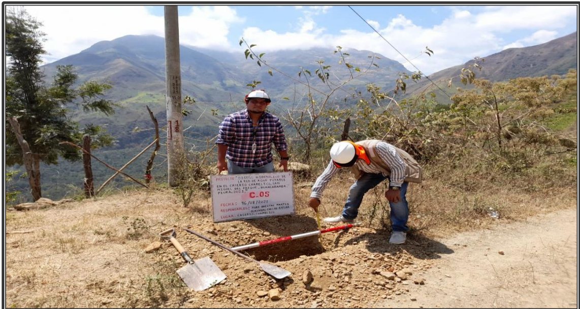
. Imagen 14. Vista panorámica de calicata C-05.
