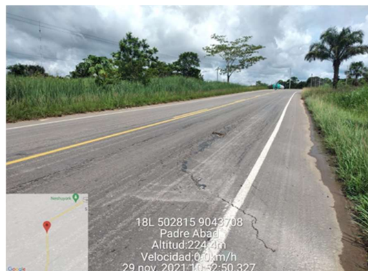
Figura 2.2. Comportamiento estructural del pavimento flexible.
