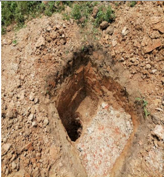
IMAGEN 3: Excavacion de la calicata
