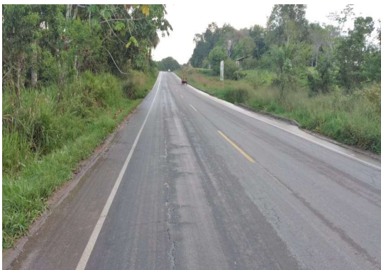
Figura 1.1. Fallas estructurales del pavimento.
