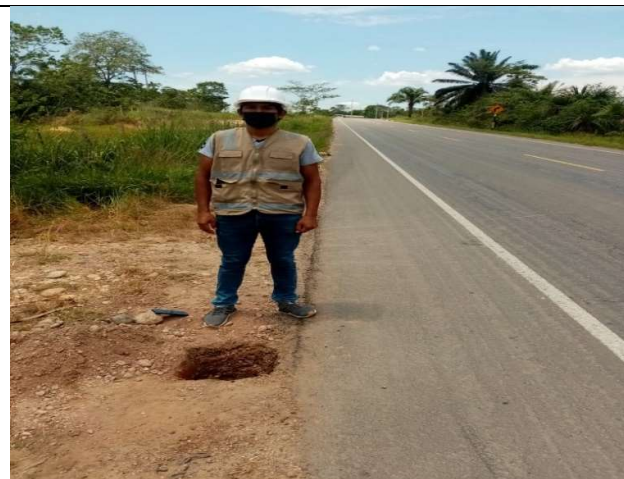
FOTO 5: CALICATA DE VERIFICACION ESTRUCTURAL
