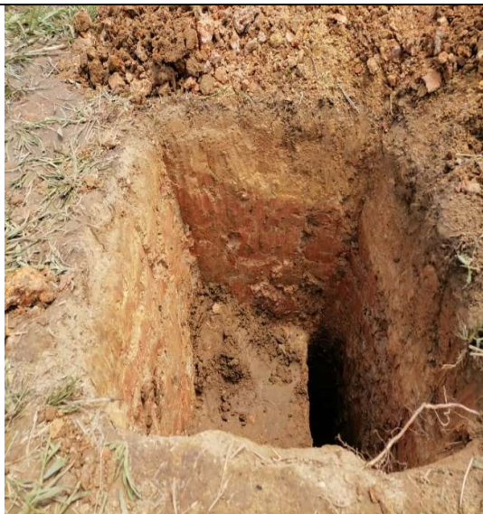
IMAGEN 3: Excavacion de la calicata
