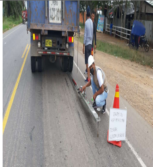
FOTO 2: REALIZANDO LOS ENSAYOS EN TRAMO RECTO
