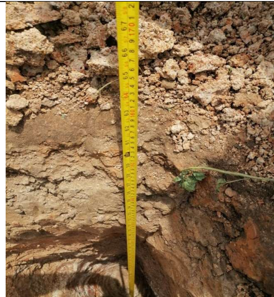
IMAGEN 4: Verificacion de la Profundidad de la calicata
