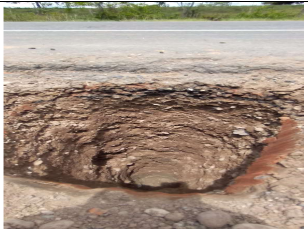
imagen 4: Verificacion de la calicata
