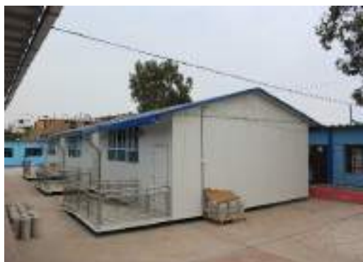
AULAS DE MATERIAL PREFABRICADO
