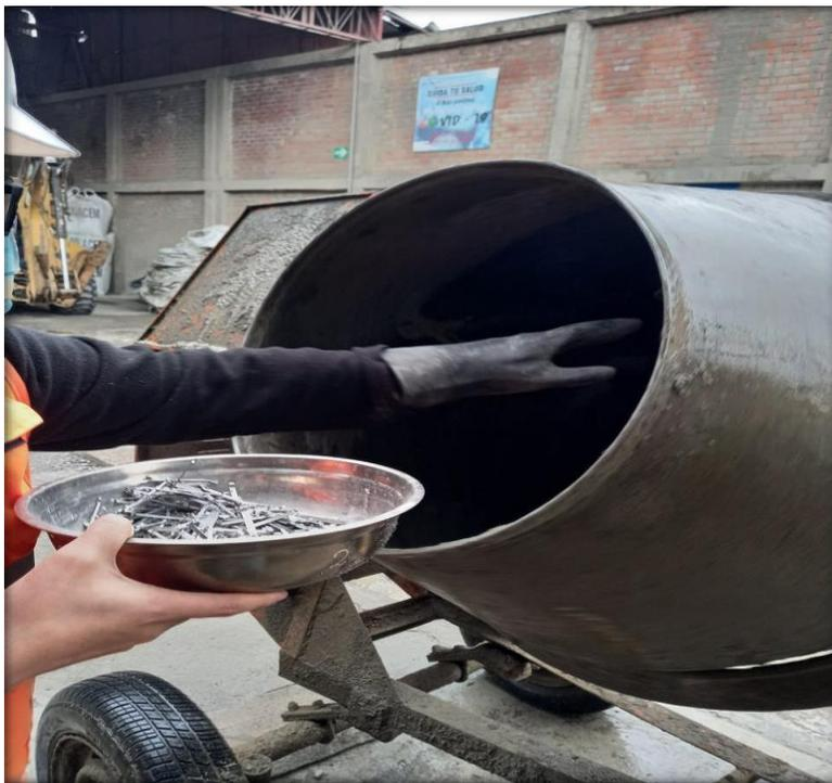
*Adición de fibra de acero de 2kg a la mezcla de concreto*
