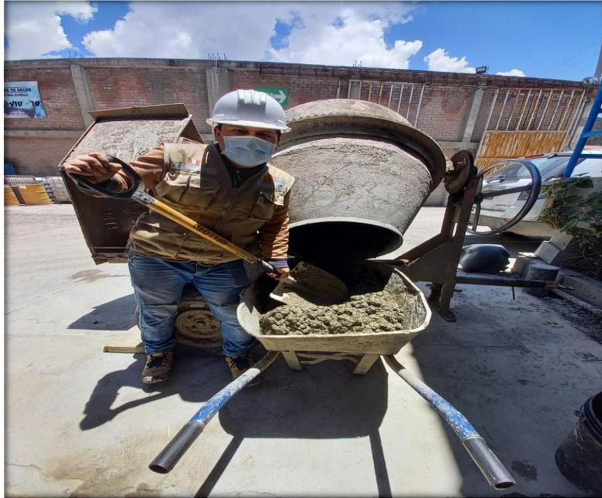
*Adición de fibra de 3kg a la mezcla del concreto*
