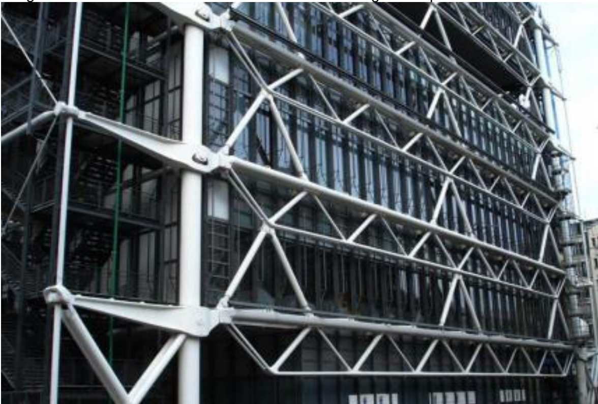
Imagen 22. Estructura de la fachada del Centro Georges Pompidou
