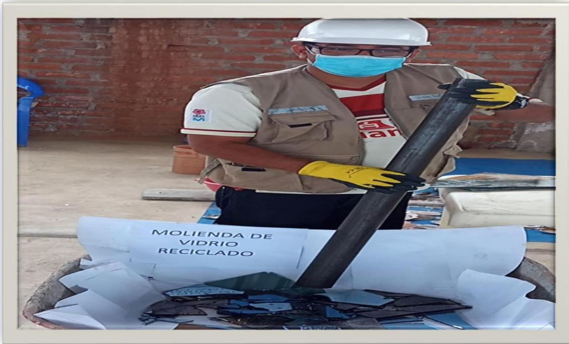
**Figura 26 y 27:** Se observa el vidrio reciclado limpio y listo para el proceso de molienda
