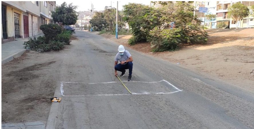
Figura N°6: Evaluación de la falla tipo ahuellamiento Fuente: Elaboración Propia
