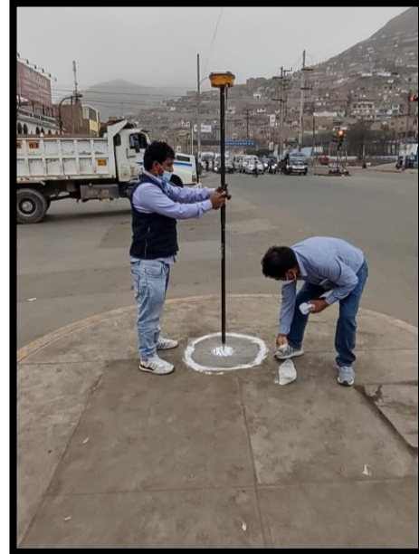
Figura 10: Colocación de puntos en vía Fuente: Elaboración Propia
