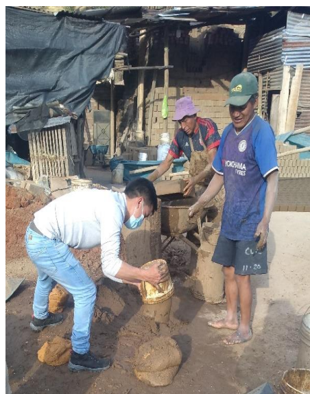
Figura 9. Sustitución de la arcilla por el Tepetate del 5%, 10% y 15%.
