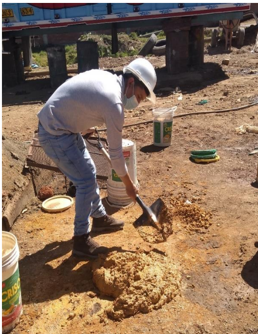
Fotografía 3. Mezcla uniforme de la masa de Tepetate
