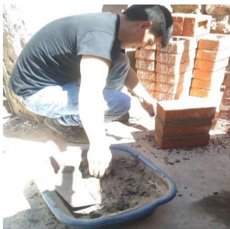
Figura 13. Fabricación de las pilas de ladrillos
