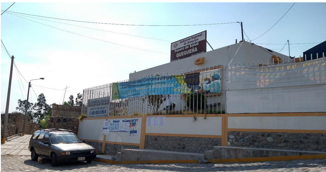
Ilustración 22: Puesto de Salud de un nivel y está ubicado tras la municipalidad .
